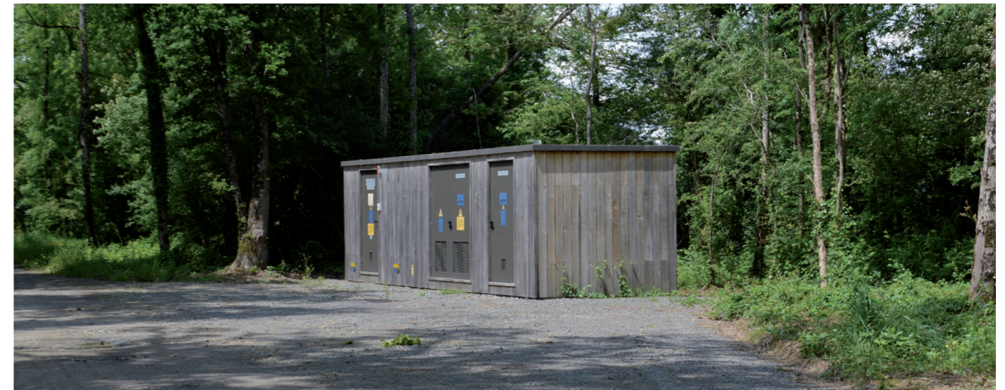
Photographie 145 : Exemple d'un poste de livraison recouvert d'un bardage bois, dans un contexte forestier (parc éolien d'Adriers-Tageau dans le département de la Vienne, 86).
