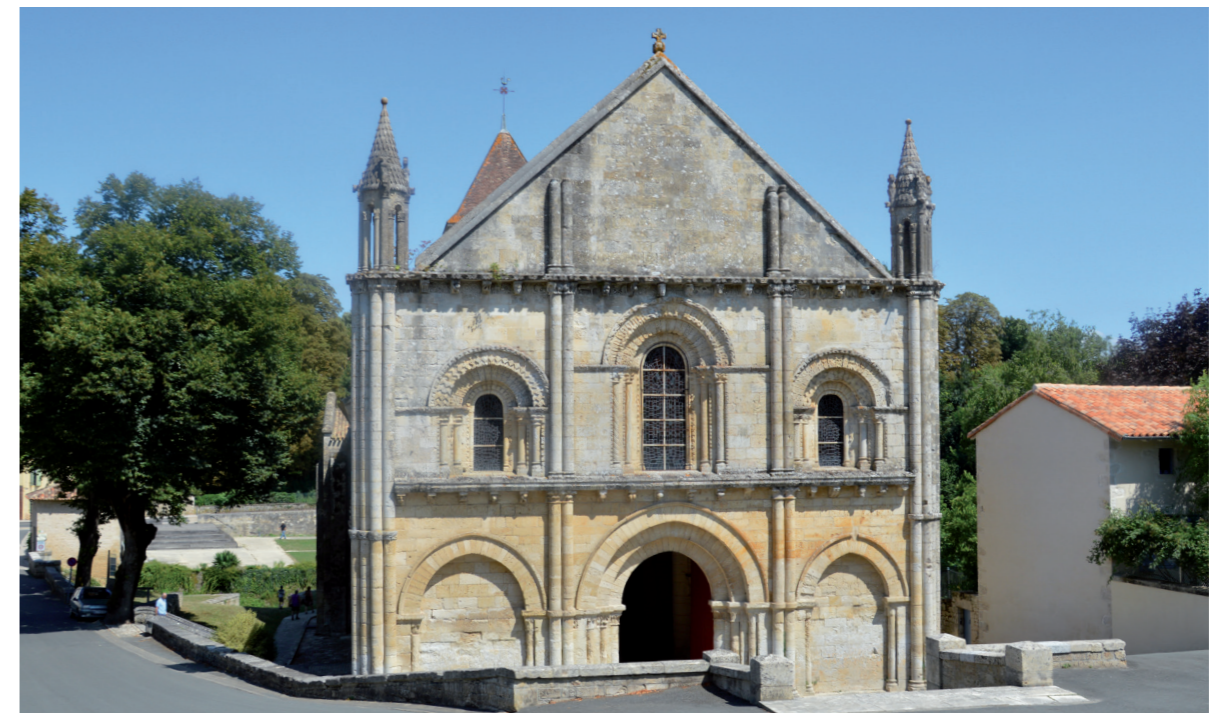
Photographie 117 : Vue sur la façade ouest de l'église Saint-Hilaire de Melle, entourée de végétation.
