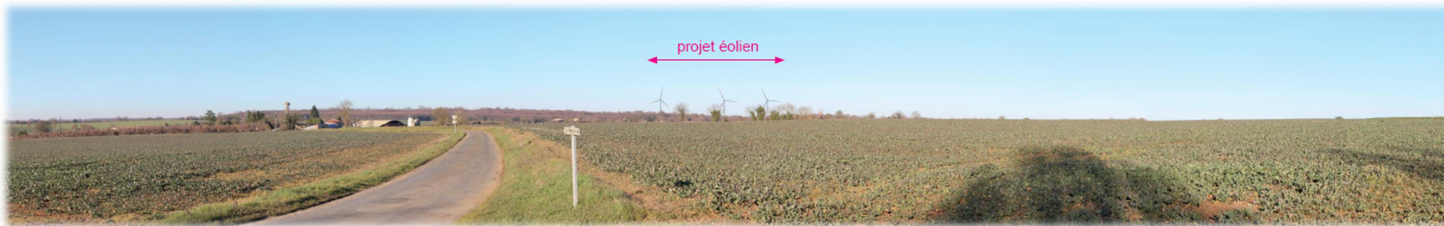
Figure 260 : Vue 120 sur le projet éolien depuis le sud du hameau de Chail, à proximité du tracé de la D948 (Vue 20 du carnet de photomontages) (Source : Étude paysagère d'ENCIS Environnement)
