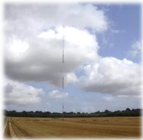
Figure 25 : Mât de mesures anémométriques du projet de la Foye (Crédit photo : NCA Environnement)
