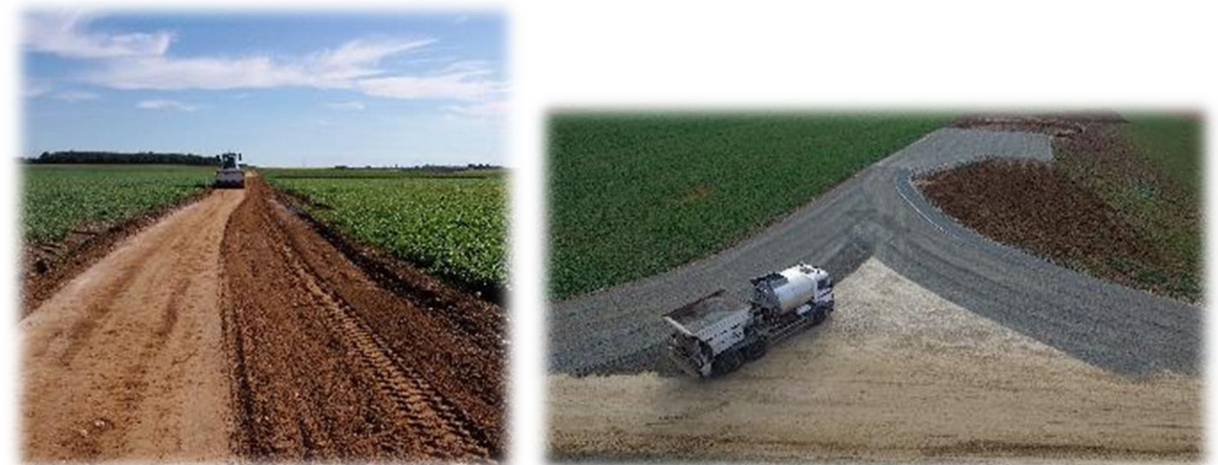
Figure 28 : Étapes de création de pistes (Source : ERG DÉVELOPPEMENT FRANCE)
