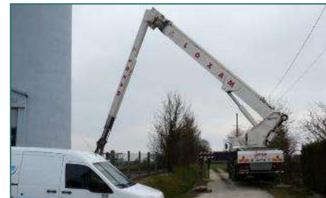
Figure 126 : Installation d'un réémetteur sur un château d'eau
