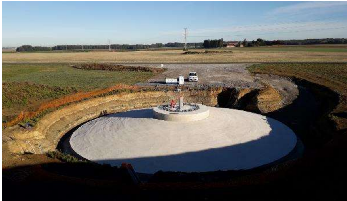
Figure 74 : Fondation après coulage béton
