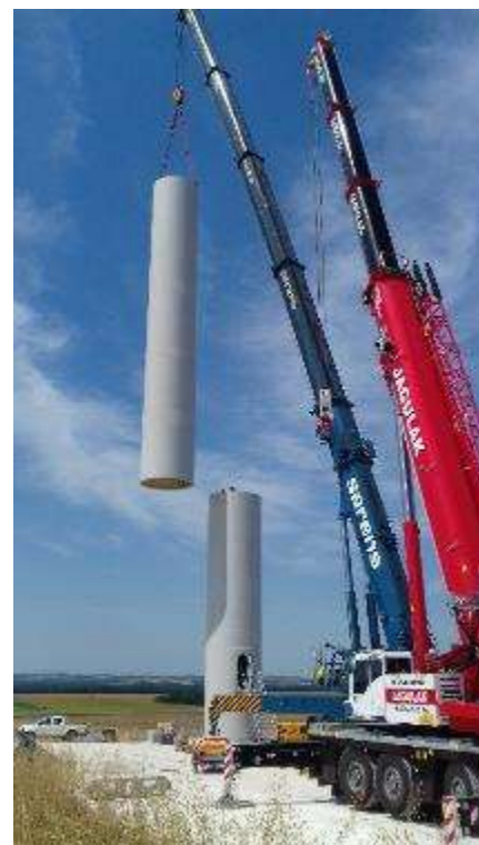
Figure 80 : Montage de la seconde section du mât
