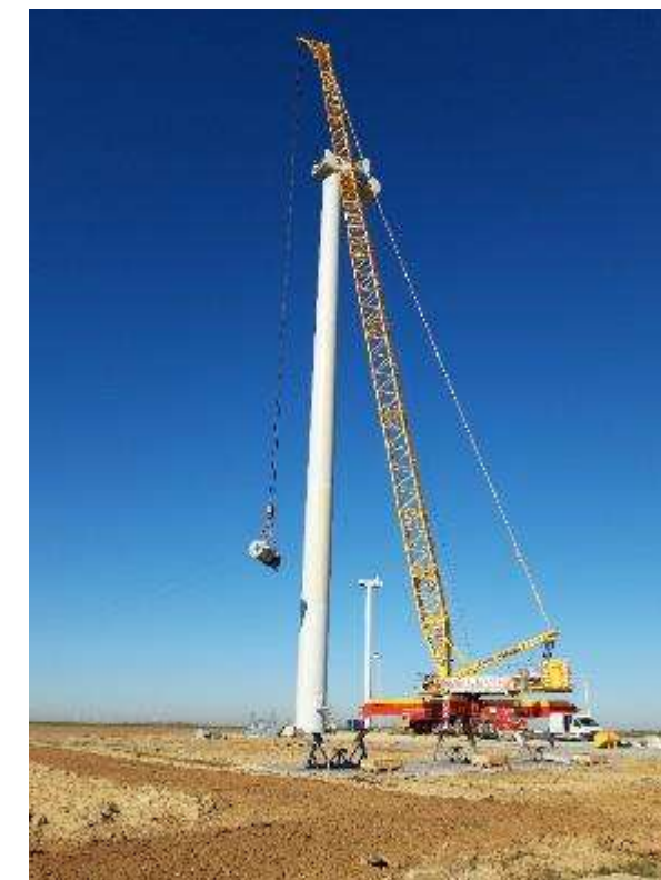
Figure 82 : Montage de la génératrice
