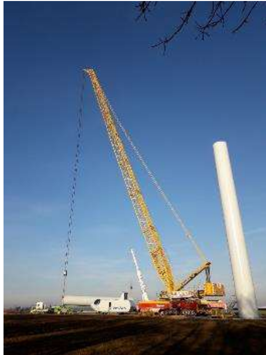
Figure 75 : Grue permettant l'assemblage des différents éléments d'une éolienne
