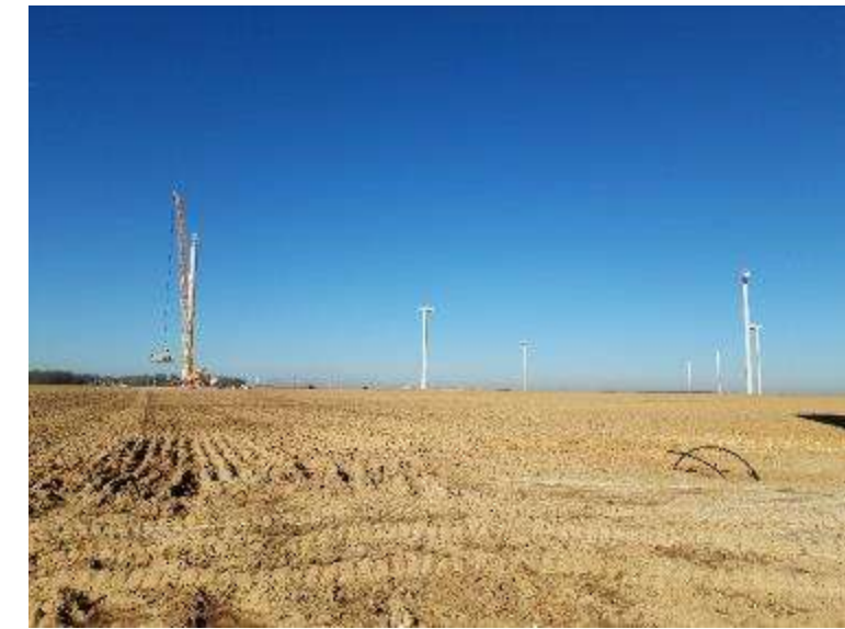
Figure 83 : Un parc de neuf éoliennes Vestas V112 en construction
