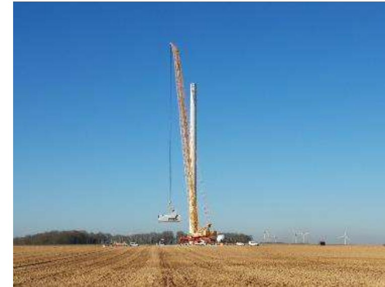
Figure 81 : Montage de la nacelle
