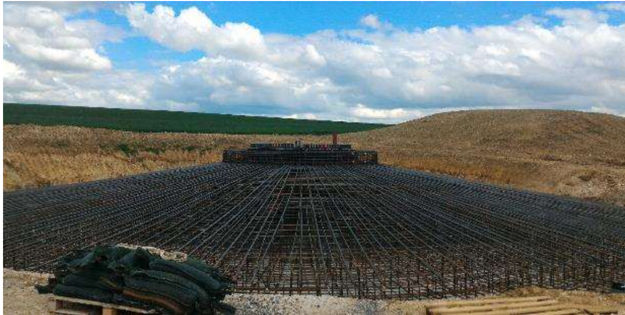
Figure 73 : Ferrailage du massif
