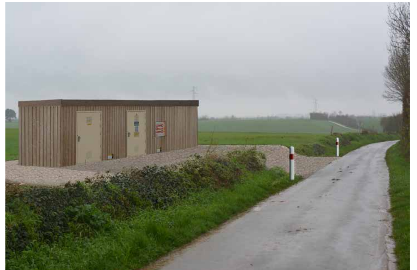
PHOTO 182 : VUE SUR UN POSTE DE LIVRAISON (PDL 2) DEPUIS UNE ROUTE COMMUNALE PRÈS DE LA RD 101
