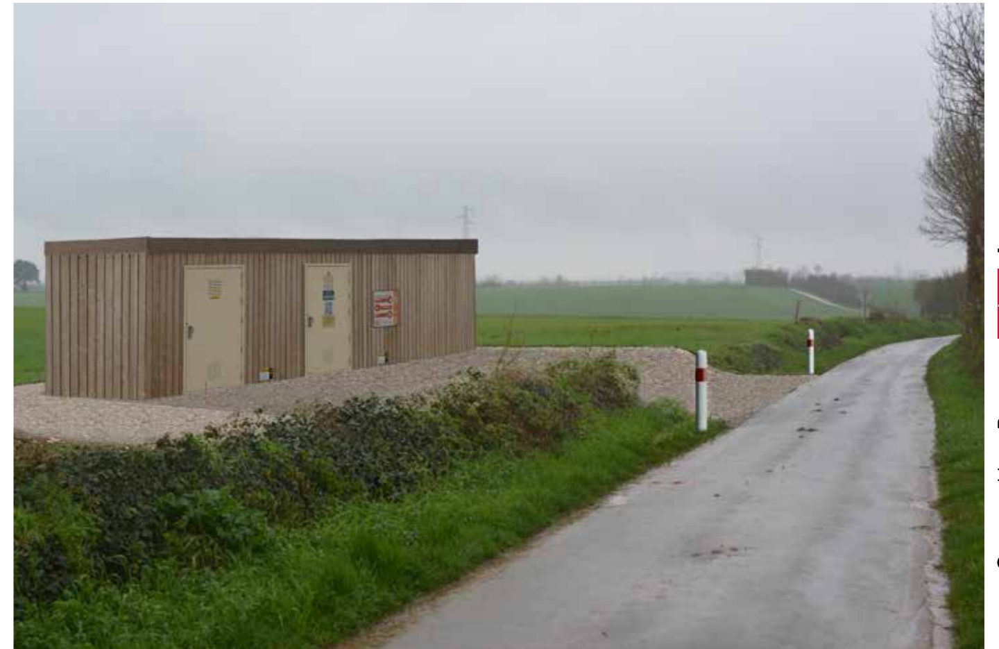
PHOTO 183 : VUE SUR UN POSTE DE LIVRAISON DEPUIS UNE ROUTE COMMUNALE PRÈS DE LA RD 101
