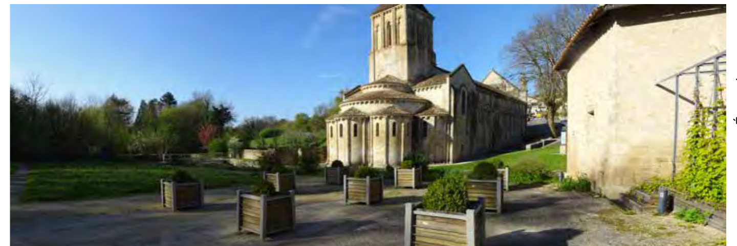
PHOTO 74 : VUE FERMÉE EN DIRECTION DE LA ZIP DEPUIS L'ÉGLISE SAINT-HILAIRE (© AGENCE COÛASNON)
