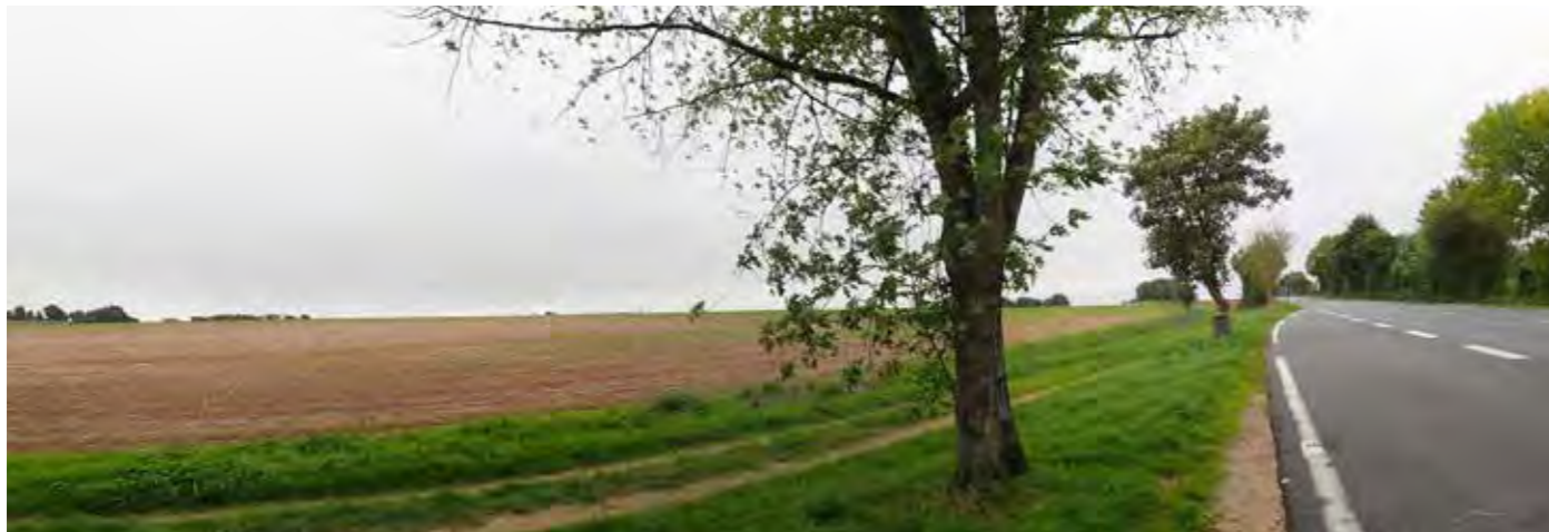
PHOTO 42 : RD 940 À PROXIMITÉ DE POUFFONDS ; L'ESPACEMENT DES ARBRES DE BORD DE ROUTE ET L'OUVERTURE VISUELLE DES CHAMPS RENDENT VISIBLE LA ZIP DEPUIS LES GRANDS AXES ROUTIERS (© AGENCE COÛASNON)
