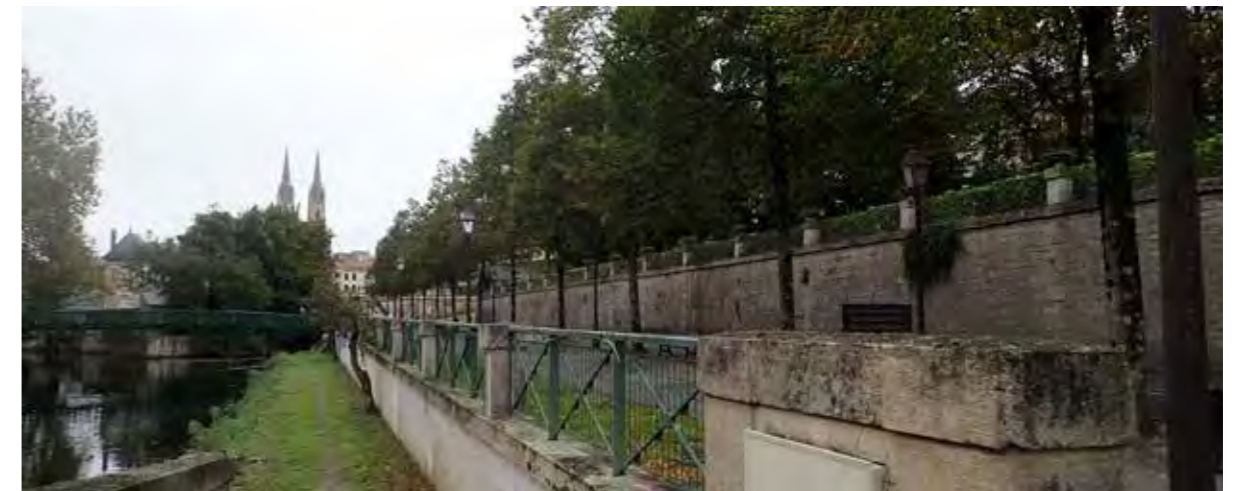
PHOTO 30 : VUE FERMÉE EN DIRECTION DE LA ZIP DEPUIS LA SÈVRE-NIORTAISE (© AGENCE COÛASNON)
