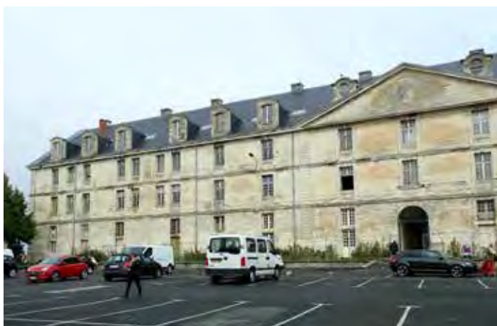
PHOTO 19 : FAÇADE DE LA CASERNE (© AGENCE COUASNON)
