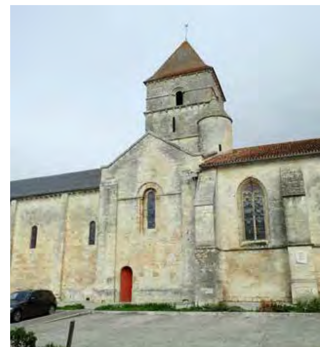
PHOTO 26 : ÉGLISE DE JAVARZAY (© AGENCE COÛASNON)
