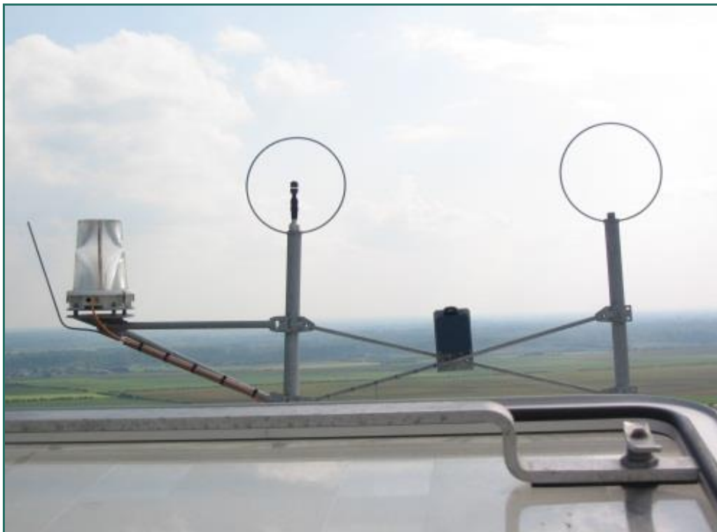
Figure 9 : Photographie d'un exemple de balisage aéronautique
