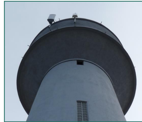
Photographie 15 : Installation d'un réémetteur sur un château d'eau.
