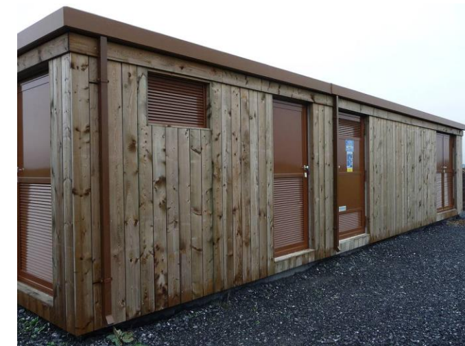
Figure 92 : Exemple d'habillage du poste de livraison
