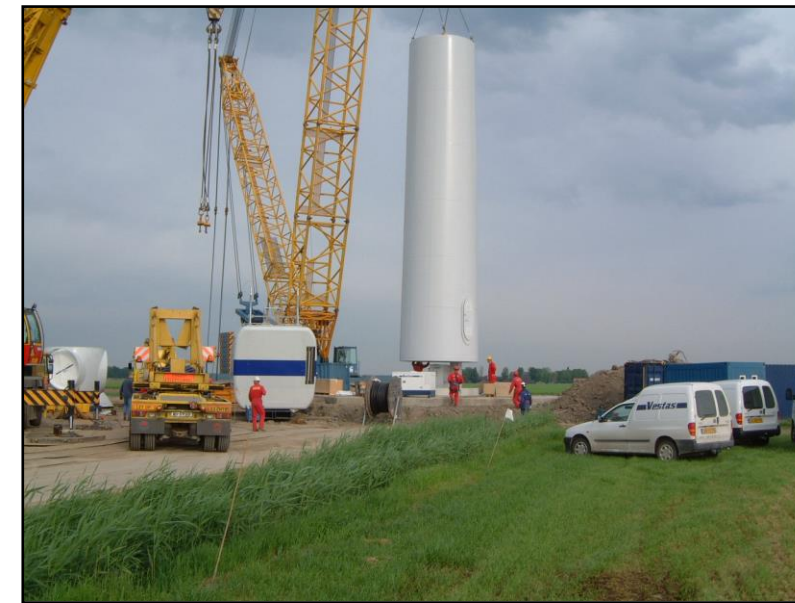
Photographie 10 : Montage de la première section du mât
