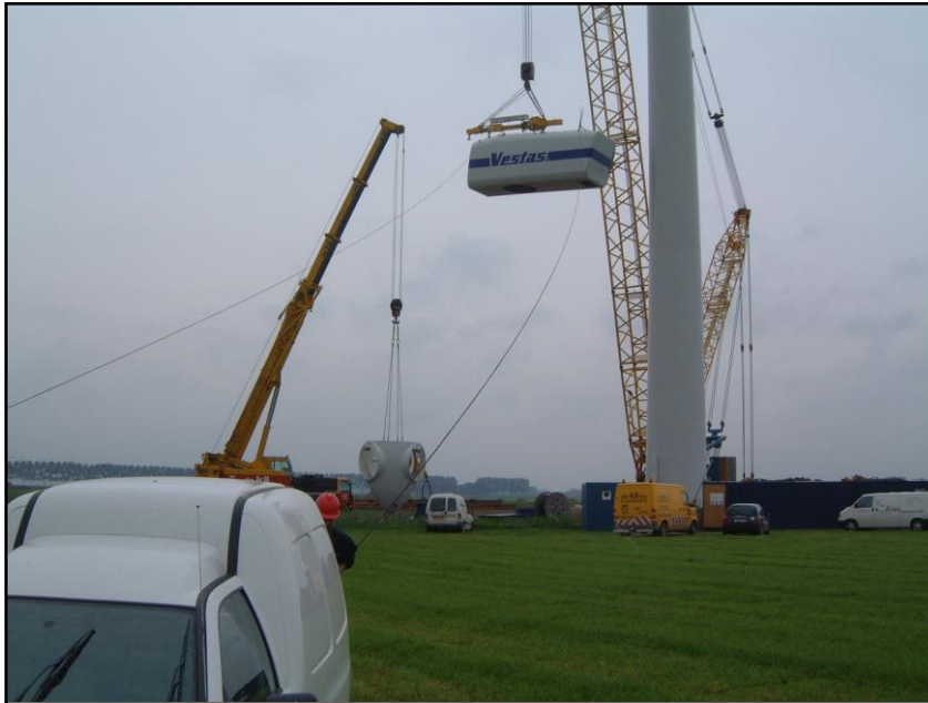
Photographie 11 : Montage de la nacelle
