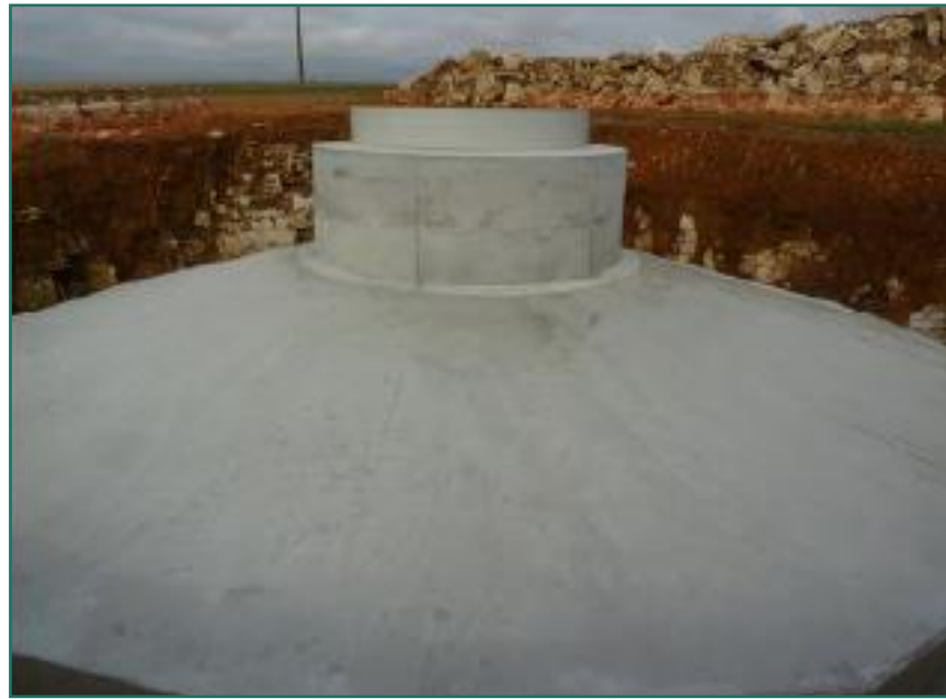
Photographie 5: Fondation après coulage béton (Source : Parc éolien de Saint-Martin-lès-Melle-VOLKSWIND-Juillet 2009)
