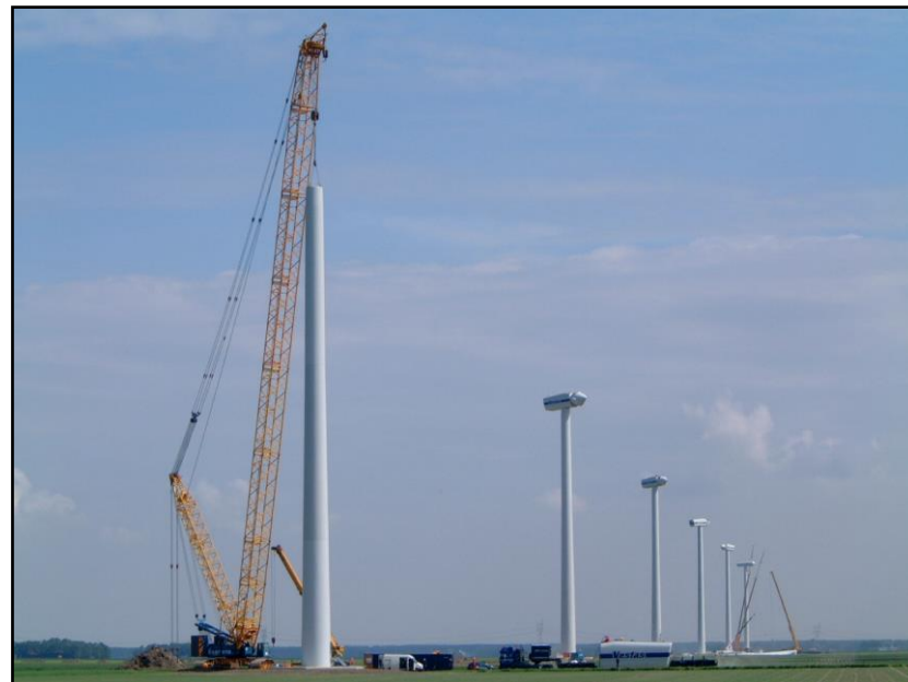
Photographie 12 : Un parc de neuf éoliennes Vestas V80 en construction
