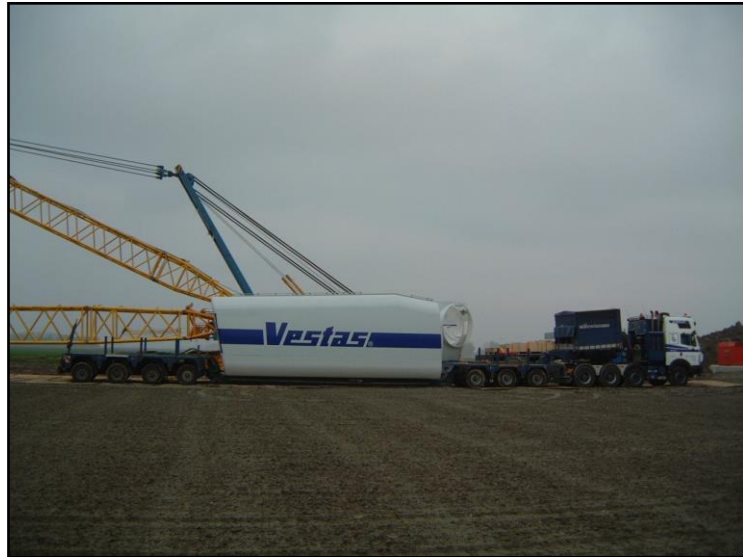
Photographie 7 : Transport de la nacelle
