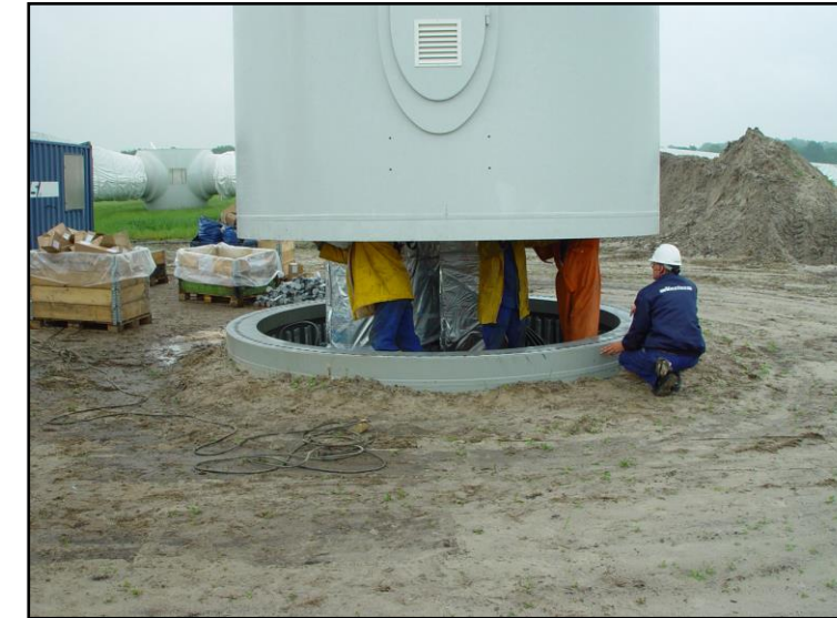
Photographie 9 : Montage du mât sur la fondation
