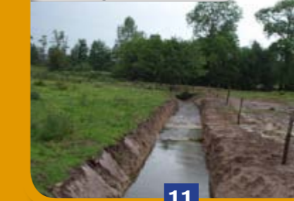
Recalibrage de cours d'eau
