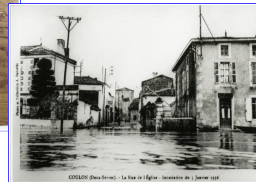
Inondation de janvier 1936 – Rue de l'Église à Coulon Source : Parc interrégional du Marais poitevin
