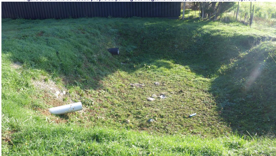
Figure 2 : Bassin du parking des magasins Komilfo, Gauthier et Atelier Majorelle
