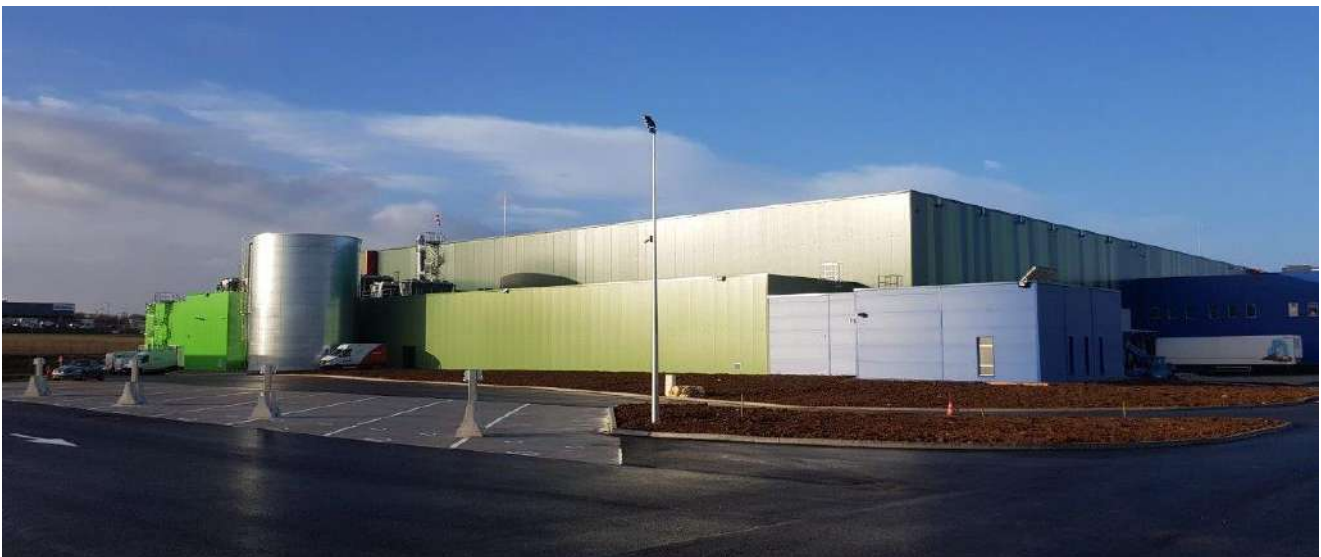
Entrepôt Frigorifique et son Extension à La Crèche (79)
