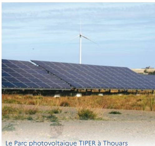
Le Parc photovoltaïque TIPER à Thouars
