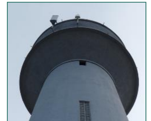
Figure 108 : Installation d'un réémetteur sur un château d'eau
