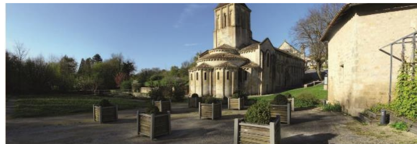
Figure 45 : Eglise Saint-Hilaire à Melle, vues fermées en direction de la ZIP (Source : Couasnon)
