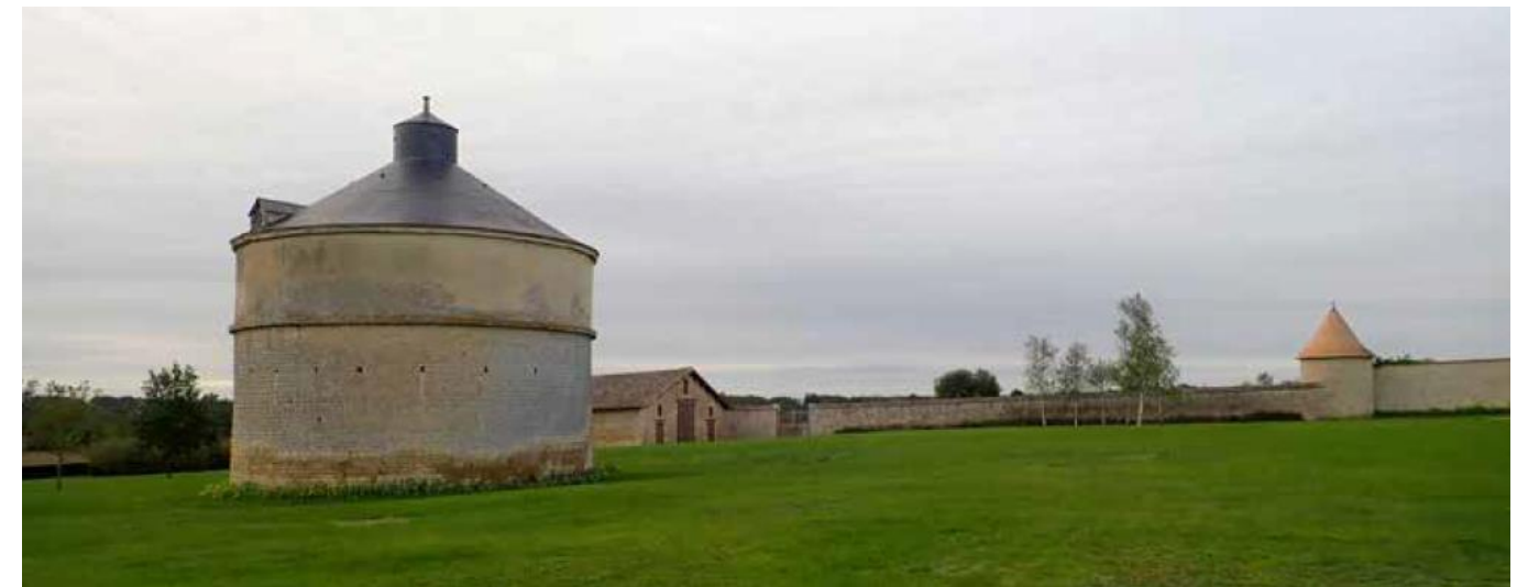
Figure 38 : Façade Nord du Domaine du Grand Port (Source : Couasnon)
