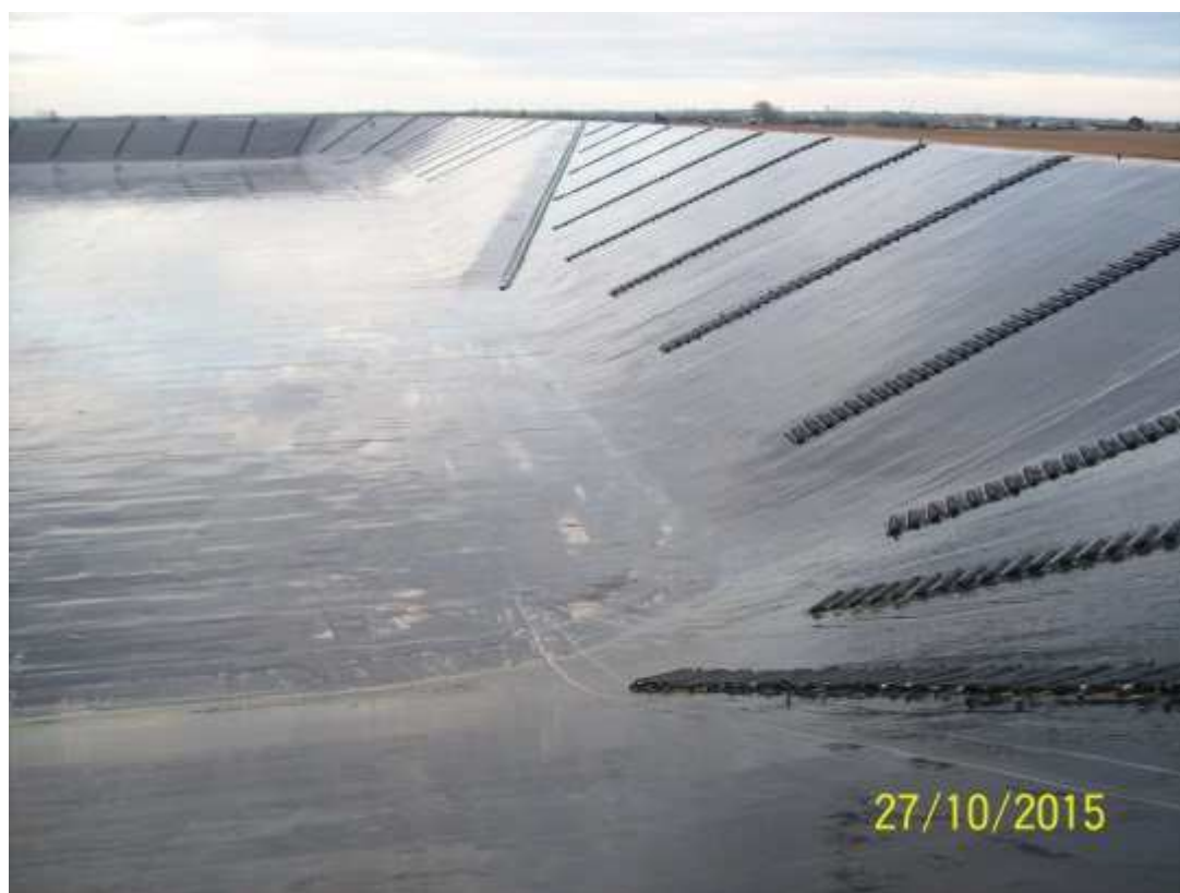
Exemple de retenue bâchée en remplissage
