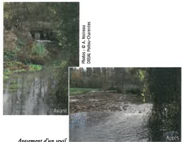
Arasement d'un seuil
