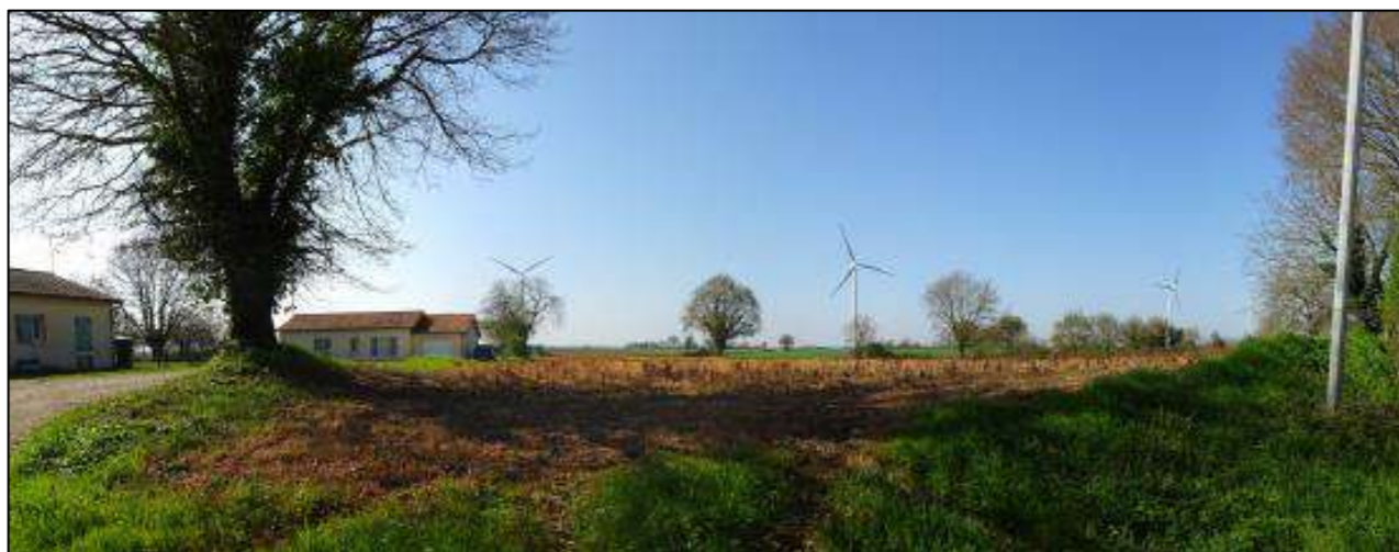
Figure 277 : La ZIP s'inscrit entre deux éoliennes existantes à l'arrière-plan - la présence du motif éolien dans le paysage quotidien atténuée légèrement ainsi la sensibilité du hameau (Source : Étude paysagère de l'Agence COUASNON)
