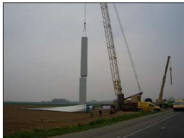
Assemblage des tronçons du mât
