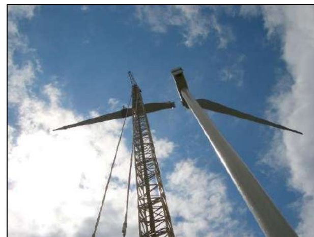
Assemblage des pales
