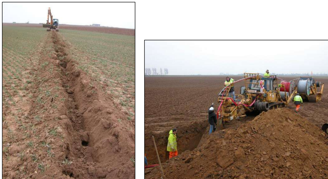
Figure 33 : Photographies d'une opération de raccordement (Source : EOLISE)
