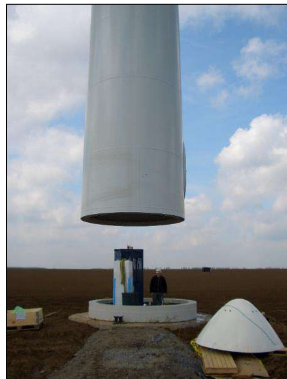
Montage de la base du mât
