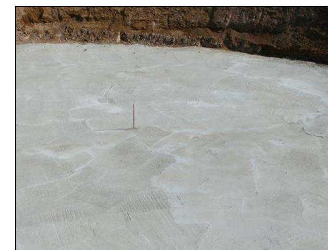
Béton de propreté
