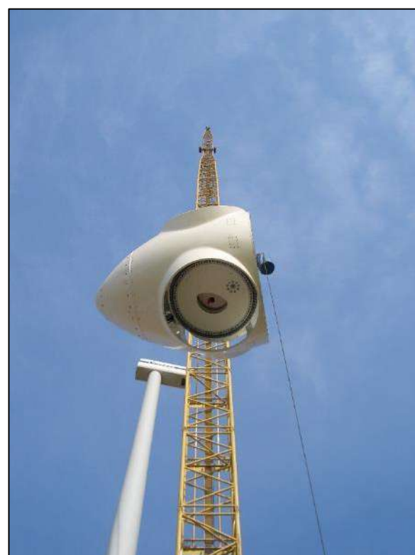
Assemblage du rotor
