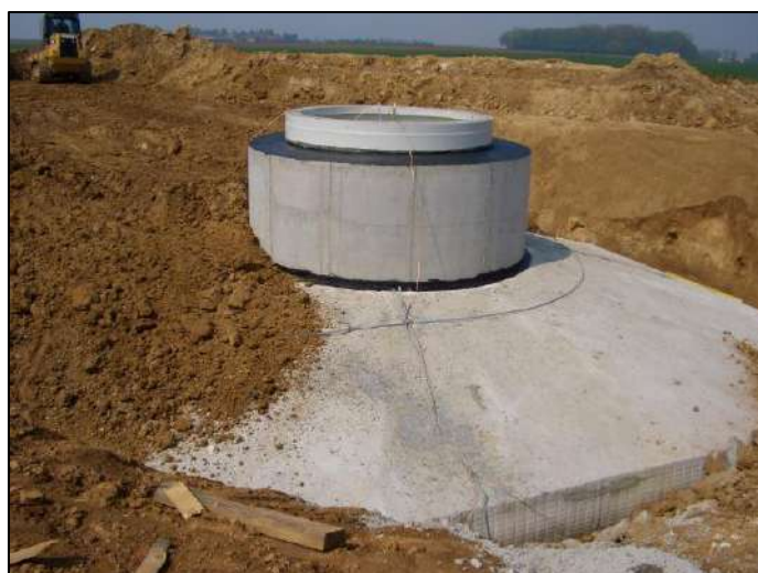
Figure 31 : Remblaiement des fondations (Source : EOLISE)
