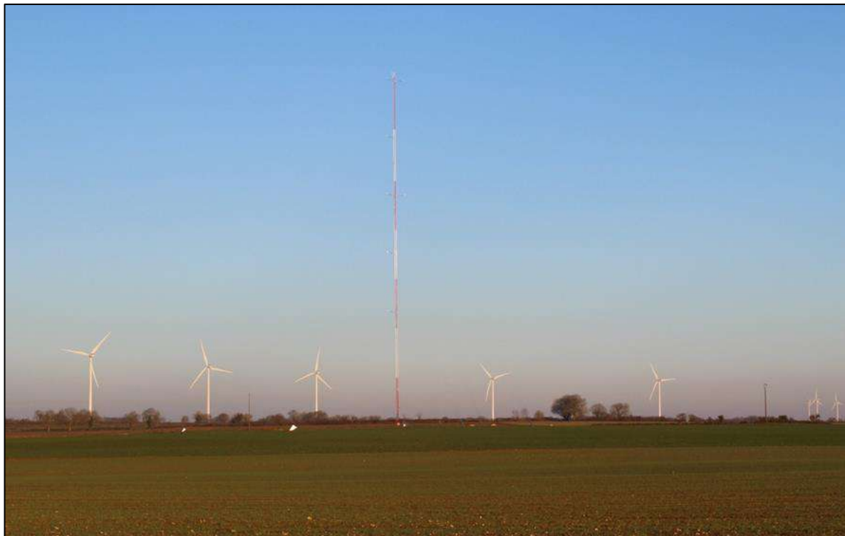
Figure 24 : Mât de mesures anémométriques du projet de la Plaine de Balusson (Crédit photo : EOLISE, janvier 2020)
