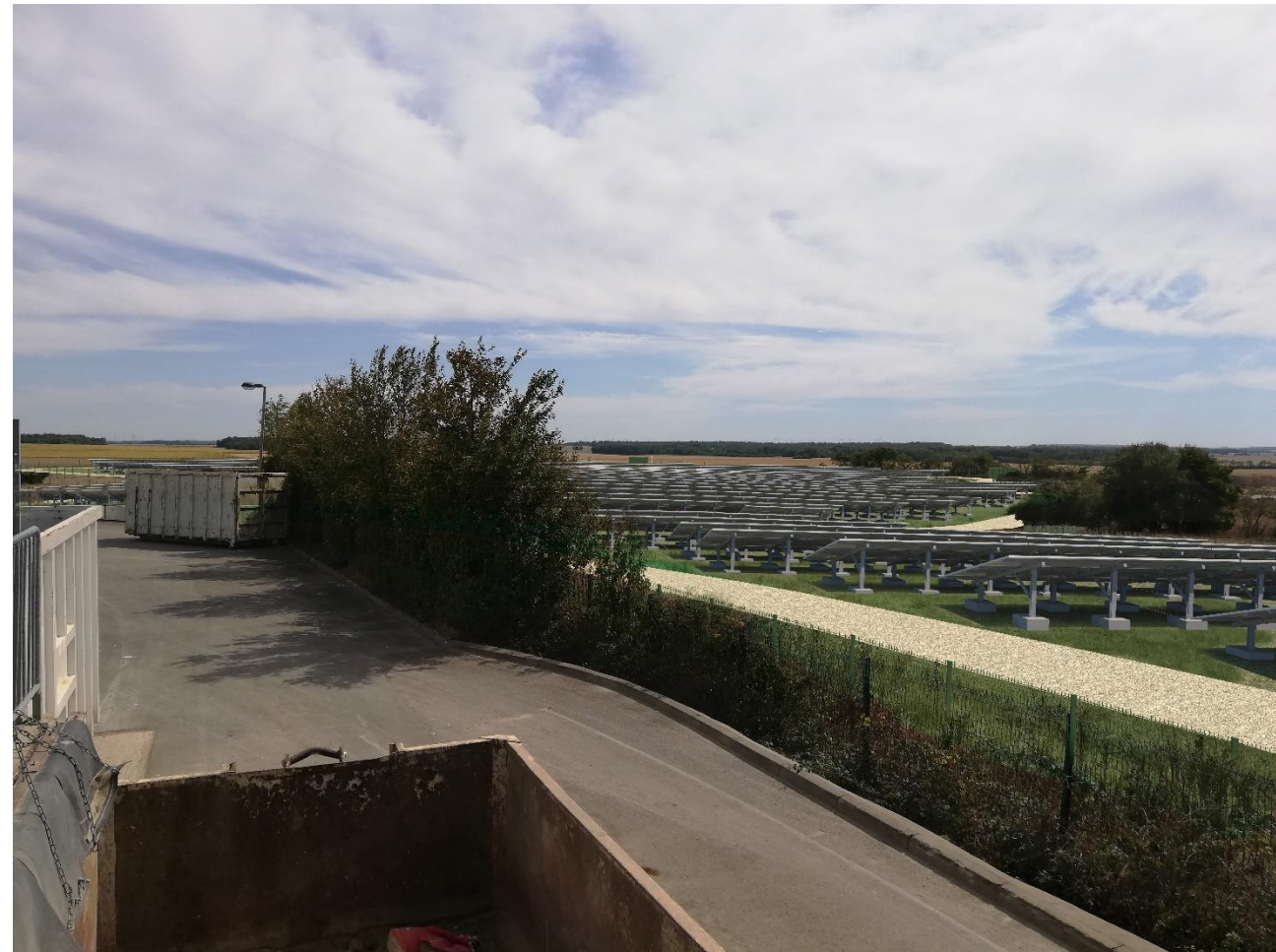
Etat final du site
