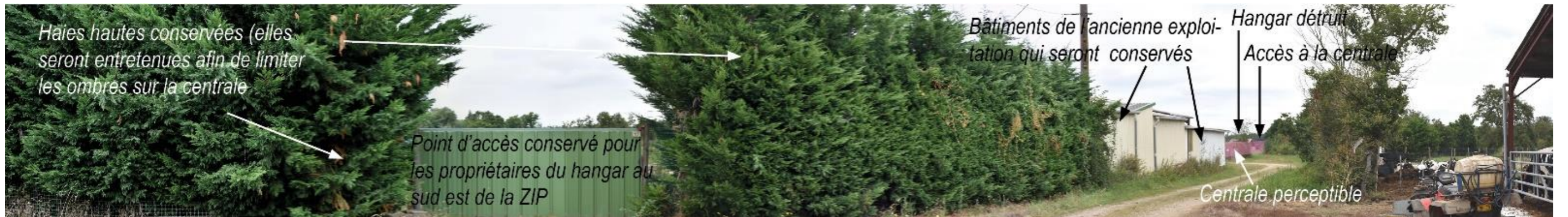
Photographie 15 : Depuis l'entrée de la centrale, panneaux photovoltaïques en grande partie masqués par les haies, portail et bâtiments existants.
