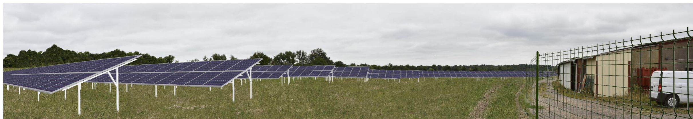
Photographie 16 : Vue depuis l'intérieur de la centrale photovoltaïque, à proximité des bâtiments existants et conservés dans le projet (source : ENCIS Environnement)
