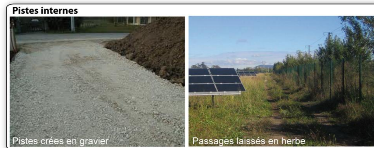
Photographie 10 : Exemple de pistes empierrées et enherbées (Source : ENCIS Environnement)
