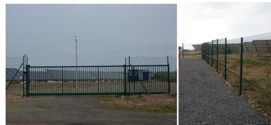
Photographie 11 : Exemple de clôture de sécurité et de portail d'accès (Source : ENCIS Environnement)
