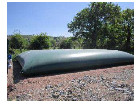
Photographie 63 : Exemple de citerne souple (source : ENCIS Environnement)
