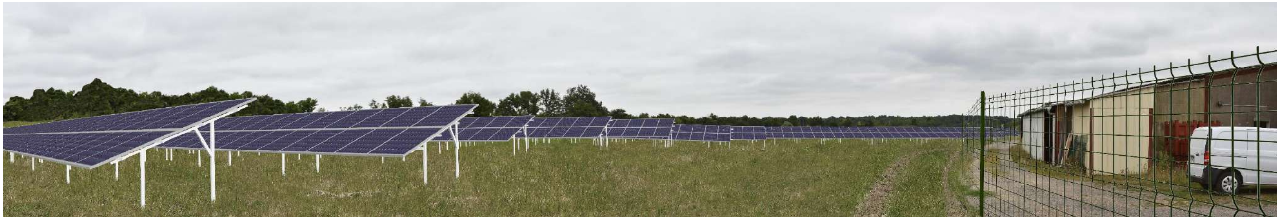
Photographie 78 : Vue depuis l'intérieur de la centrale photovoltaïque, à proximité des bâtiments existants et conservés dans le projet – Localisation de la prise de vue sur la carte précédente (source : ENCIS Environnement)
