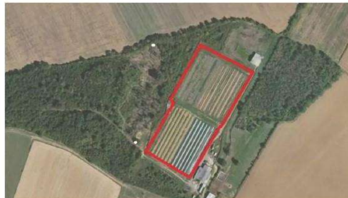
Un projet photovoltaïque pourrait voir le jour sur le site de l'ancien élevage de visons de « L'Humeau-Jouanne ».
