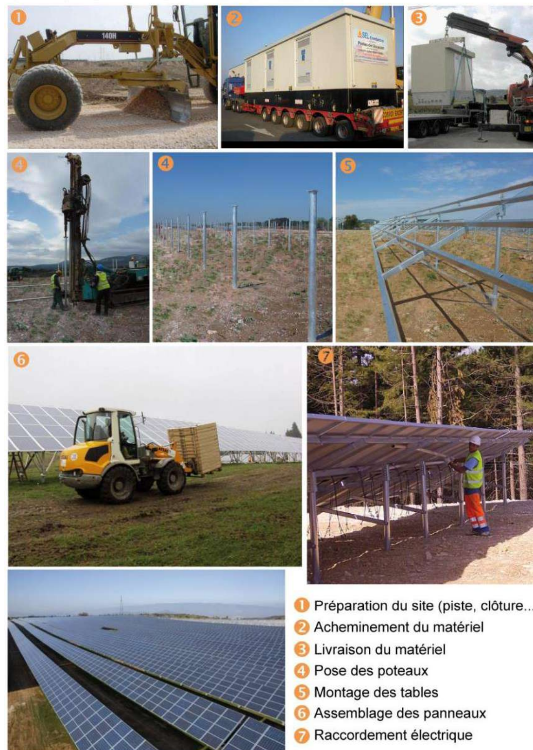
Photographie 64 : Construction d'une centrale photovoltaïque (Source : ENCIS Environnement)
