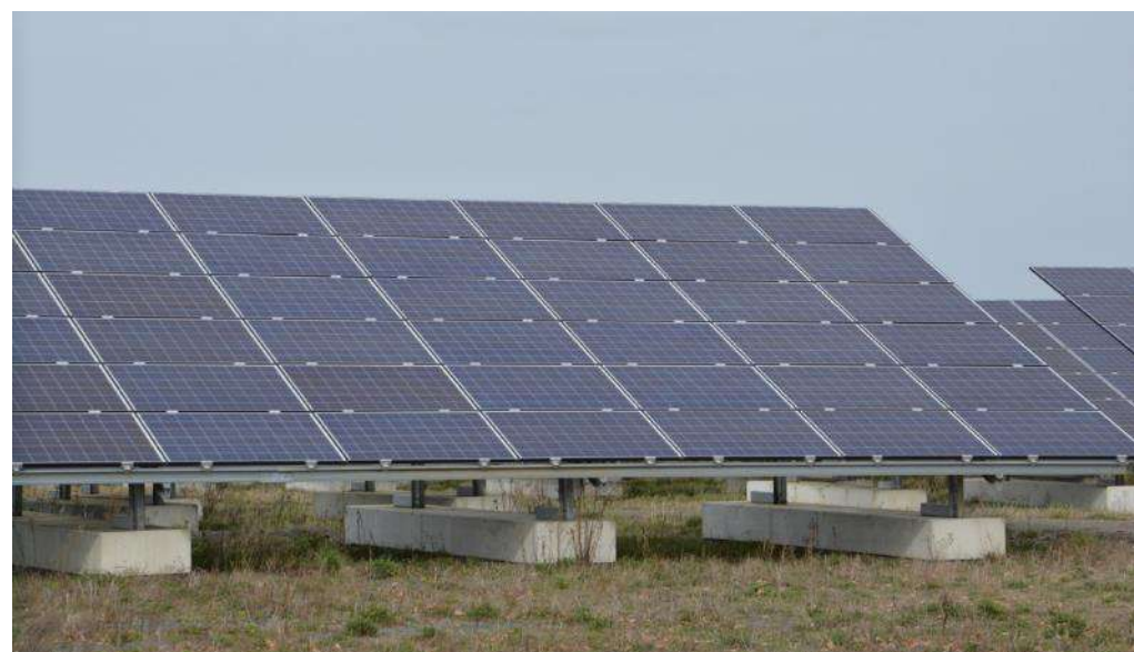
Photographie 58 : Exemple de fixation avec des plots en béton (longrines) (source : ENCIS Environnement)
