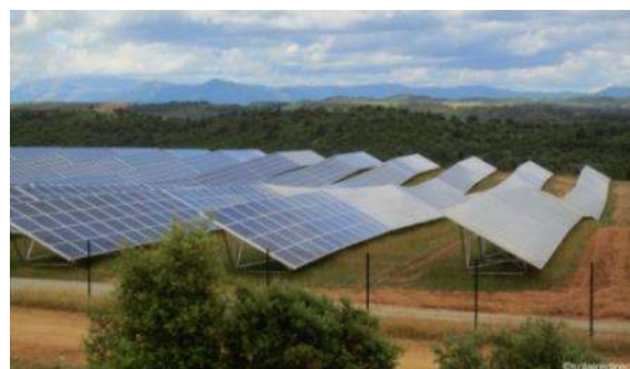
Photographie 56 : Exemple d'installation photovoltaïque au sol
