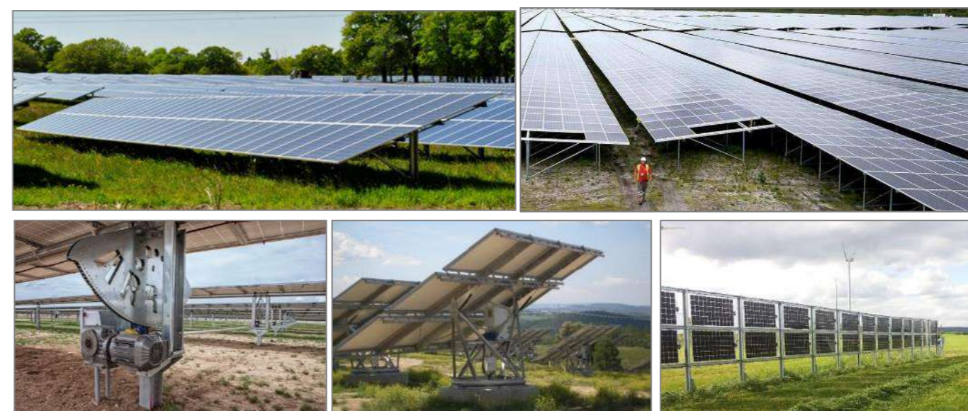
Figure 3 : Différents modes d'installations photovoltaïques au sol (Source : ENCIS Environnement, NEOEN, EXOSUN, NEXT2SUN)
