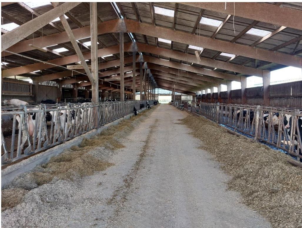
Figure 5 : Photo prise à l'intérieur du bâtiment
