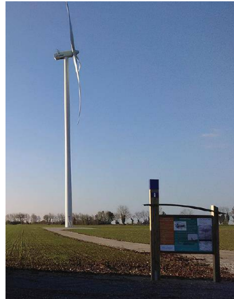
Figure 117 : Exemple de panneau d'information – Parc éolien de Lusseray – Paizay-le-Tort (79)
