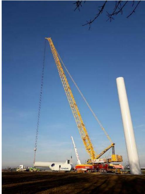
**Figure 81 : Grue permettant l'assemblage des différents éléments d'une éolienne**
