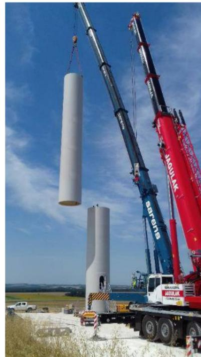
**Figure 86 : Montage de la seconde section du mât**
