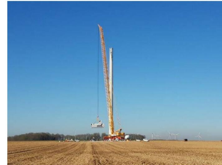
**Figure 87 : Montage de la nacelle**
