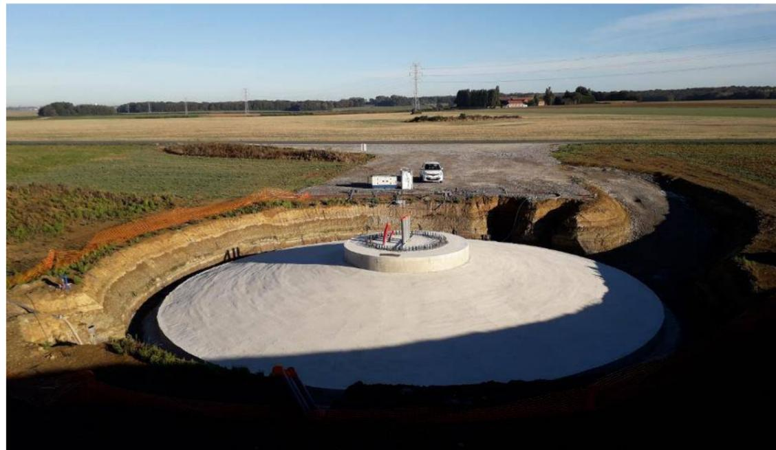
**Figure 80 : Fondation après coulage béton**
