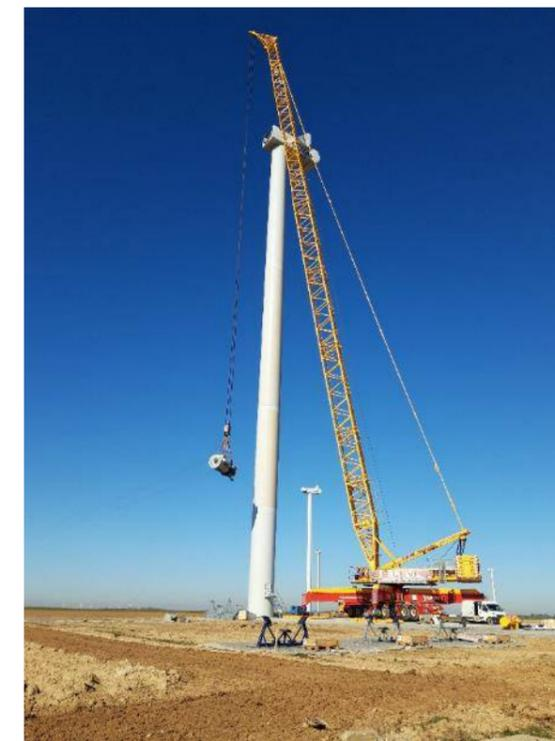
**Figure 88 : Montage de la génératrice**
