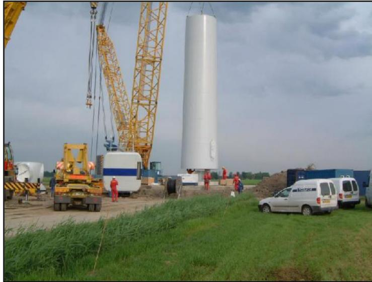
**Figure 85 : Montage de la première section du mât**
