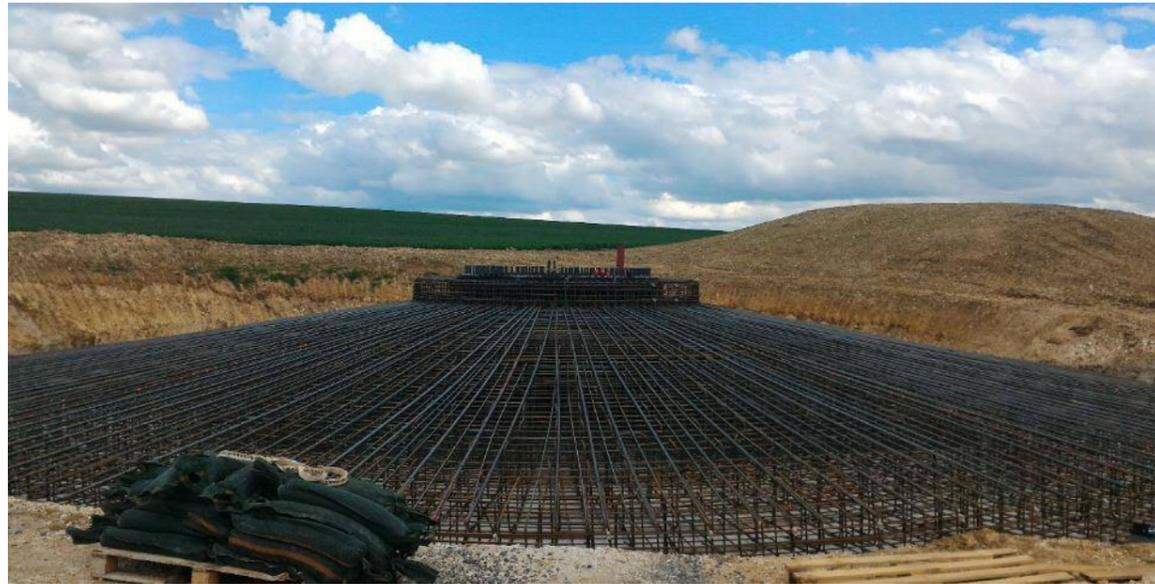
**Figure 79 : Ferrailage du massif**
