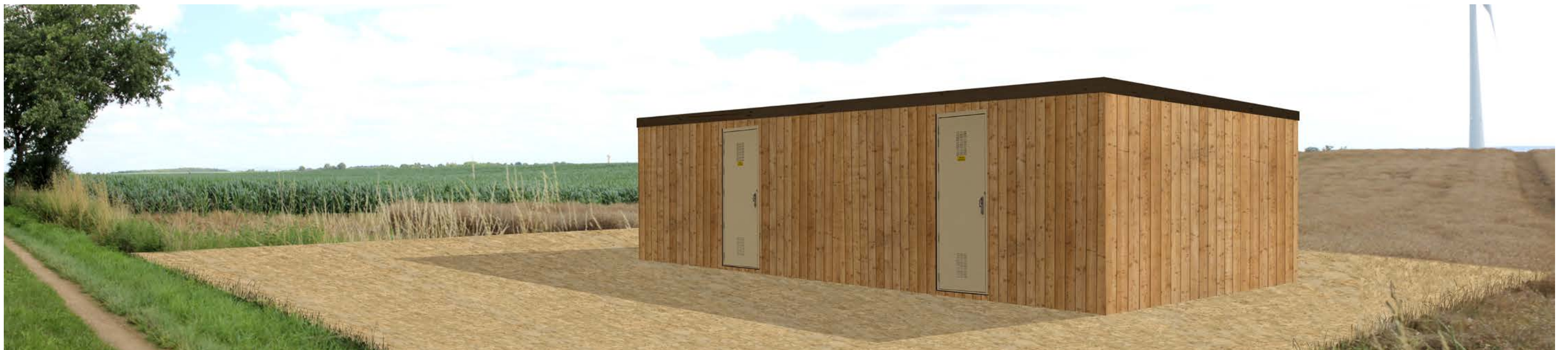
Photo 99 : Vue sur le poste de livraison le long d'un sentier agricole prêt de l'éolienne E04
