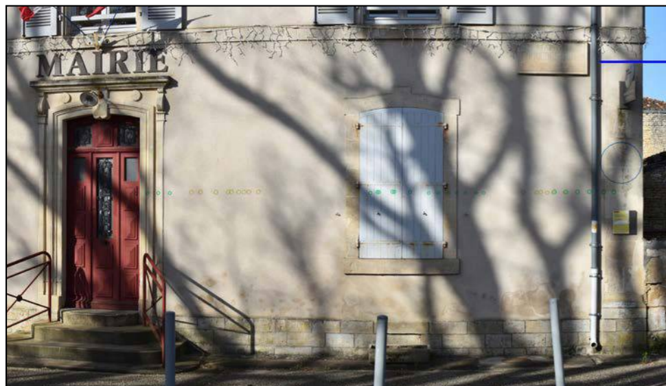
4 - PHOTOSIMULATION - ( Éolienne en service Éolienne accordée Éolienne instruite MRAE Éolienne instruite sans MRAE Projet éolien des Genêts ) - Vue 3x40°
