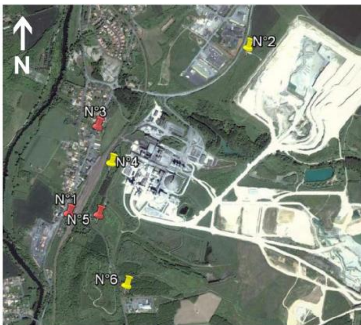
Figure 69 : Localisation des ZER à proximité de la cimenterie (Source : Rapport de mesures de bruit ENCEM de décembre 2019)
