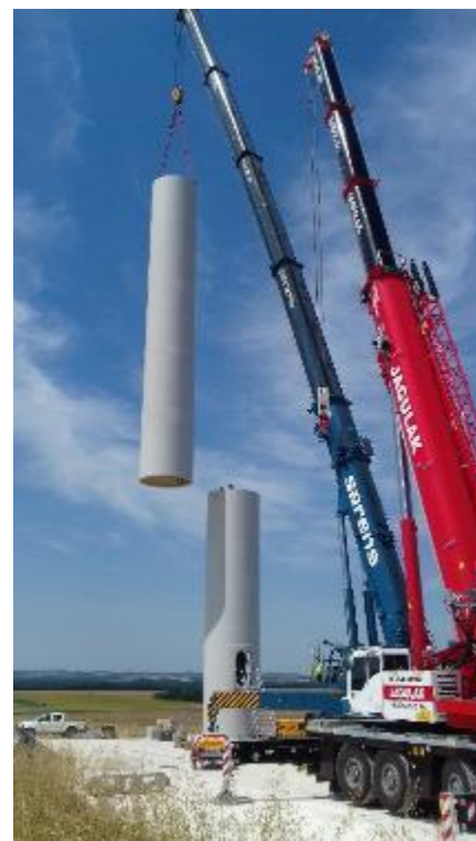
Figure 82 : Montage de la seconde section du mât
