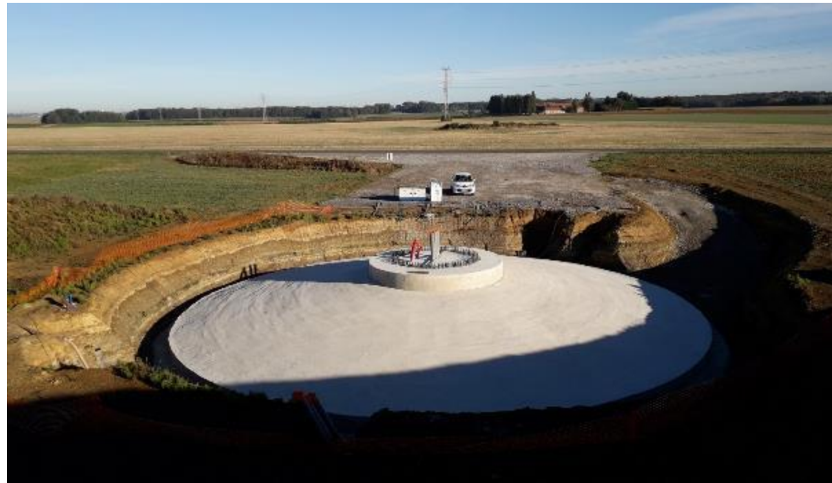
Figure 76 : Fondation après coulage béton
