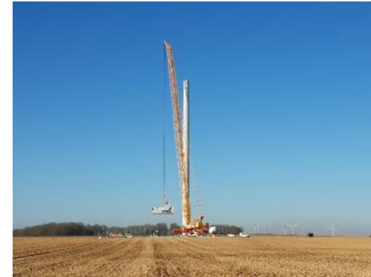
Figure 83 : Montage de la nacelle
