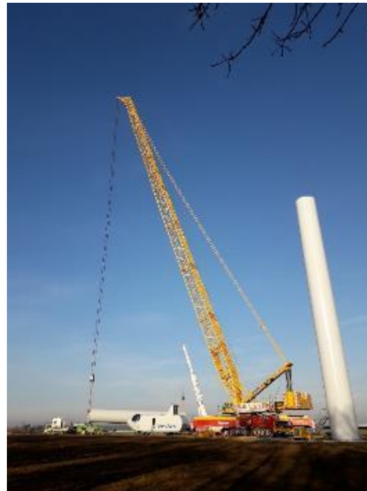
Figure 77 : Grue permettant l'assemblage des différents éléments d'une éolienne
