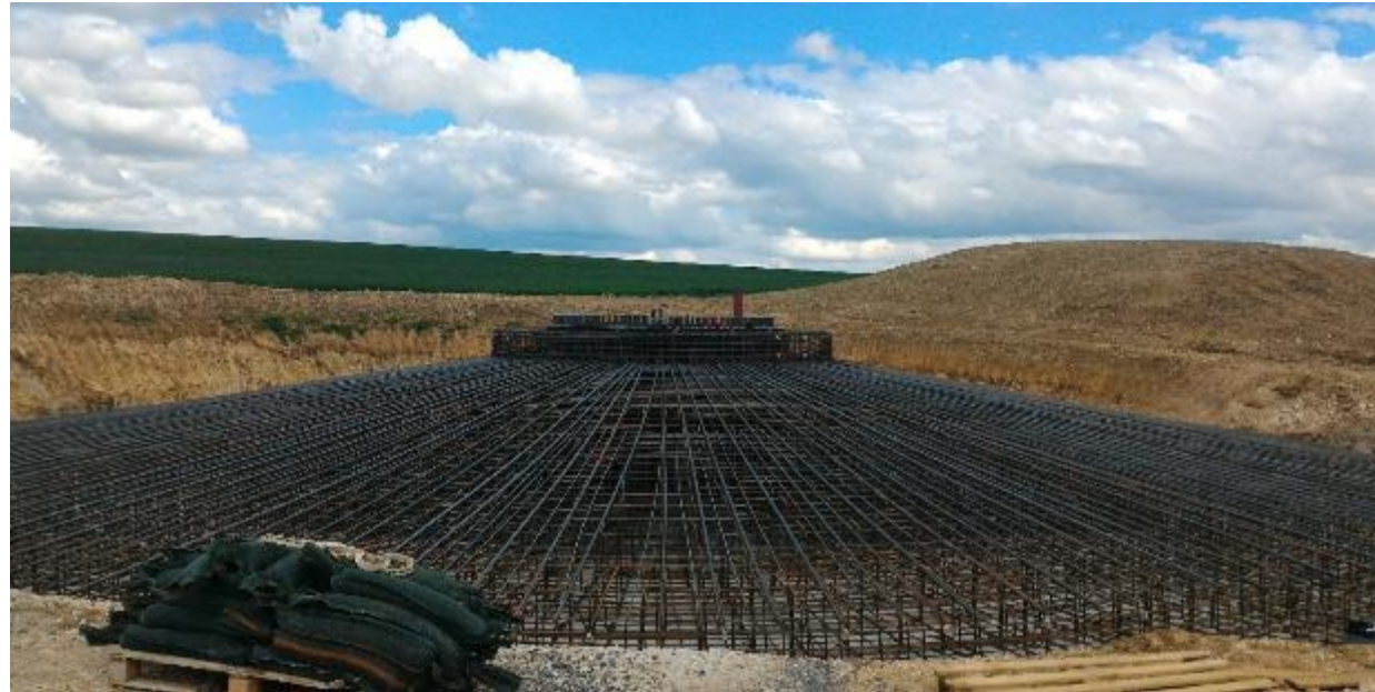
Figure 75 : Ferrailage du massif
