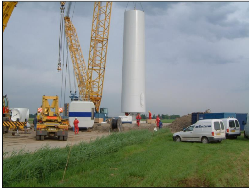
Figure 81 : Montage de la première section du mât
