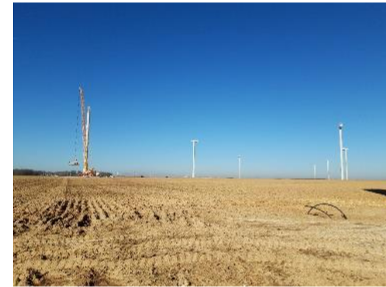
Figure 85 : Un parc de neuf éoliennes Vestas V112 en construction
