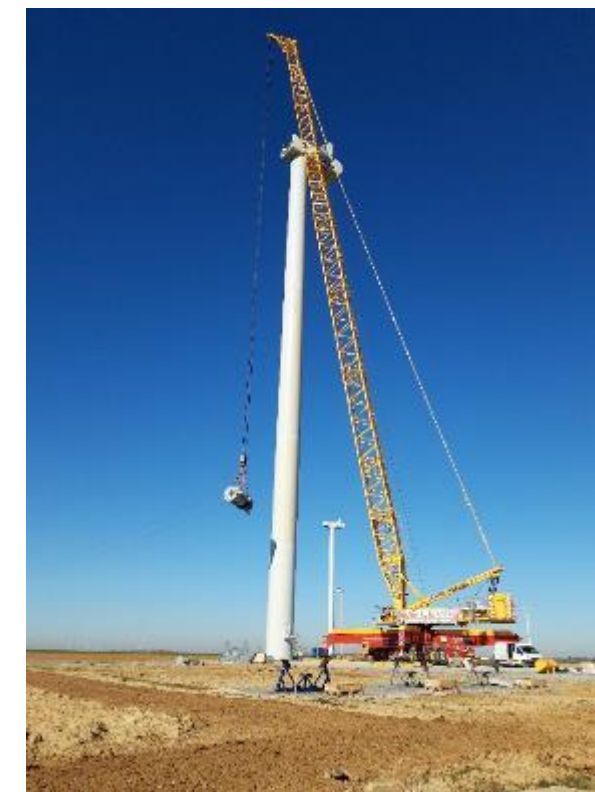
Figure 84 : Montage de la génératrice
