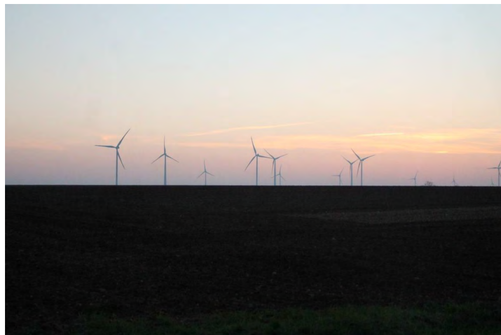
Figure 125: Ferme éolienne Lusseray-Paizay le Tort, photo prise sur site, ©NCA Environnement, 2019.
