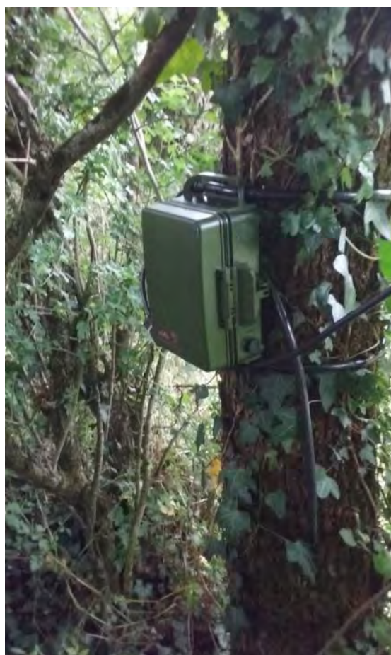
Figure 13 : Installation d'enregistreur continu SM4BAT
