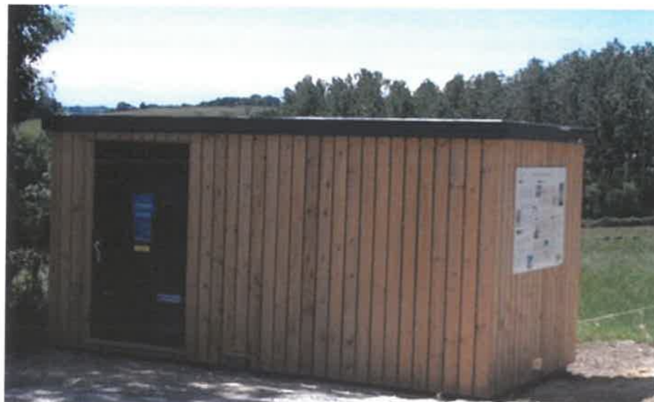
Figure 352 : Illustration de postes de livraison avec un bardage bois
