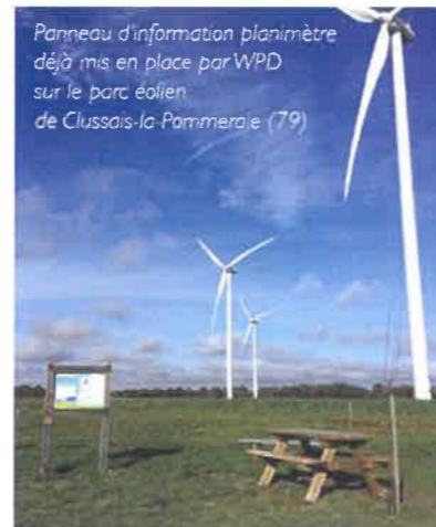
Figure 348 : Panneau d'information planimètre déjà mis en place par WPD
