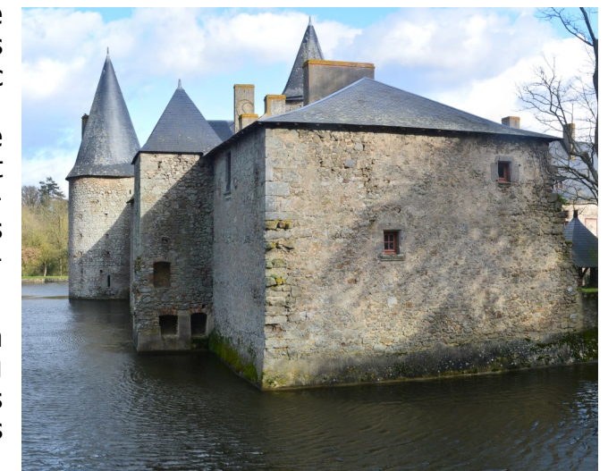
Château de Maisontiers
