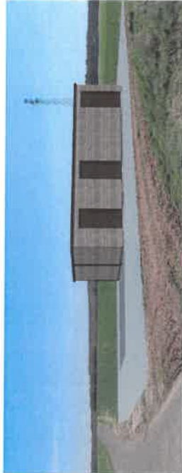
Figure 80 : Simulation d'intégration du poste de livraison avec bardage bois teinté naturelle (retenu) (source : Ouest am)
