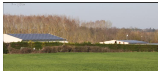
Panneaux toitures photovoltaïques de la déchetterie
