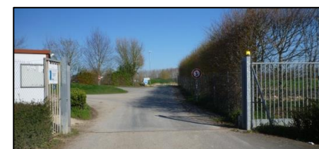
Portail d'entrée de la déchetterie
