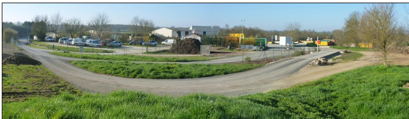
Vue sur l'entrée des installations de la déchetterie de Chef-Boutonne
