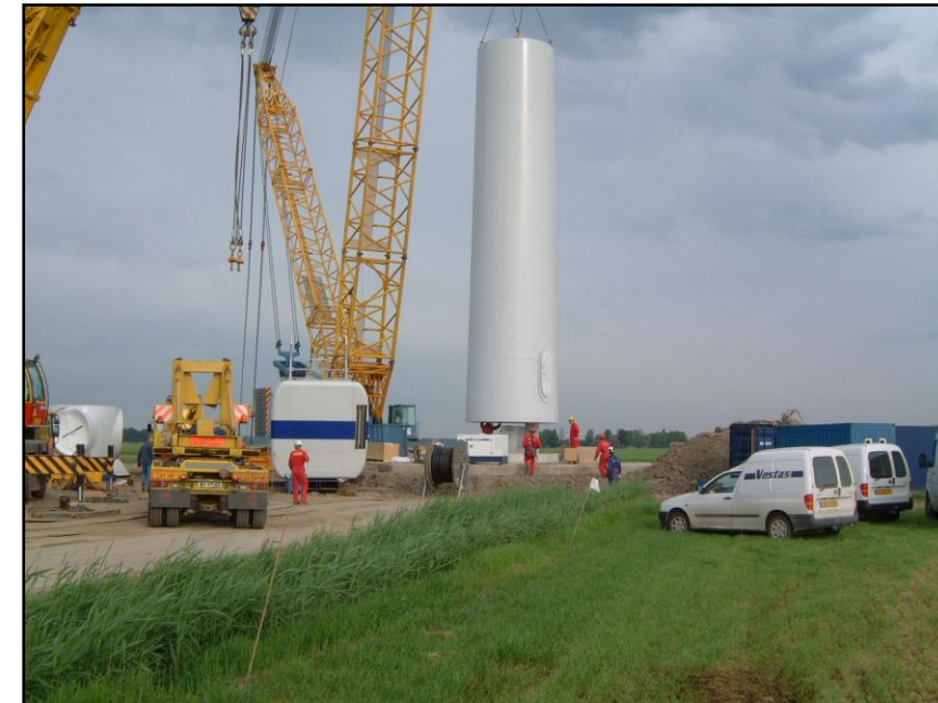
Photographie 9 : Montage de la première section du mât
