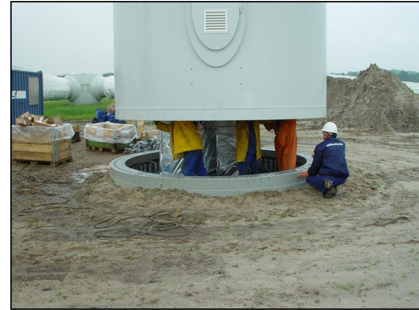
Photographie 8 : Montage du mât sur la fondation
