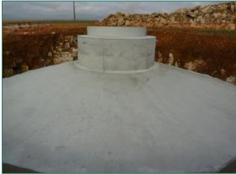
Photographie 4: Fondation après coulage béton (Source : Parc éolien de Saint-Martin-lès-Melle-VOLKSWIND-Juillet 2009)
