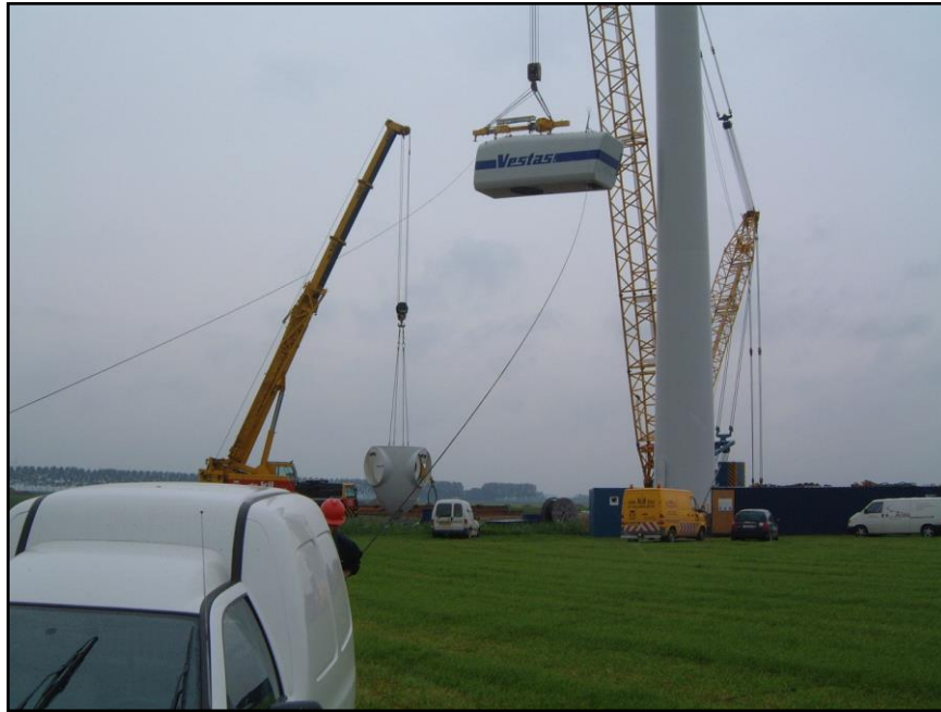
Photographie 10 : Montage de la nacelle
