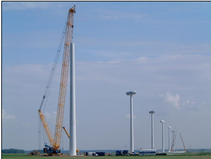
Photographie 11 : Un parc de neuf éoliennes Vestas V80 en construction
