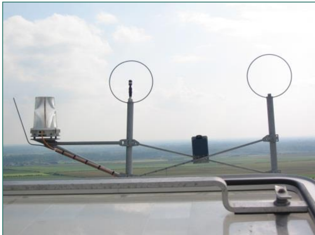
Figure 14 : Photographie d'un exemple de balisage aéronautique
