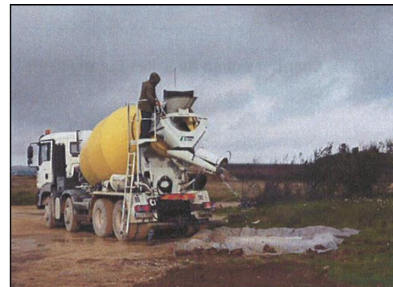
Illustration 164 : Utilisation d'un géotextile filtrant pour le lavage des camions-toupies
