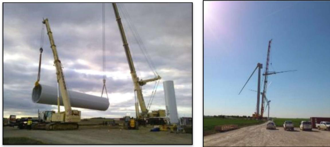
Figure 10 : Montage des éléments du mât (à gauche) et de l'hélice « pale par pale » (à droite)
