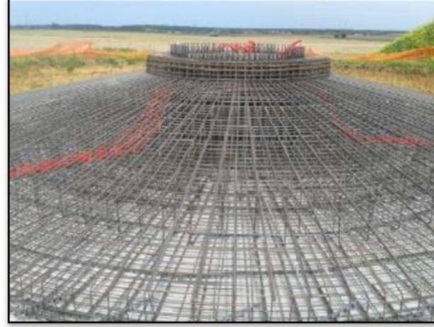
[Figure 8 : Coulage du béton de propreté \(à gauche\) et ferrailage du massif de fondation \(à droite\)](#)
