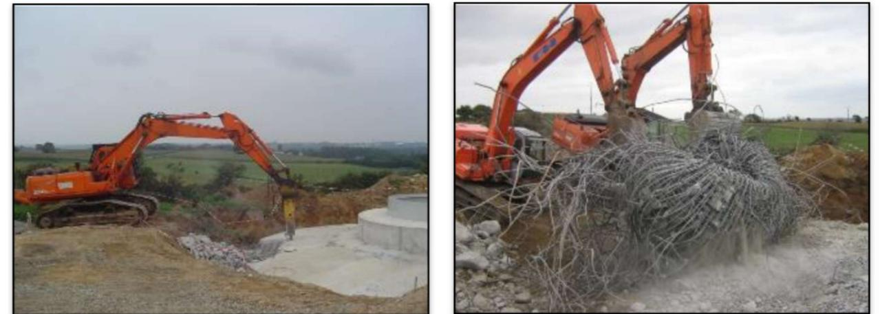
Figure 15 : Eclatement des fondations (à gauche) et enlèvement du ferrailage (à droite)
