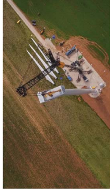
Figure 6 : vue du montage de l'éolienne n°10
