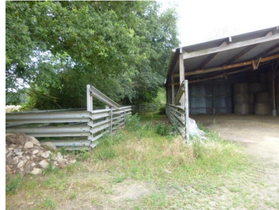
Figure 6 : Hangar de stockage situé à proximité de l'éolienne E2
