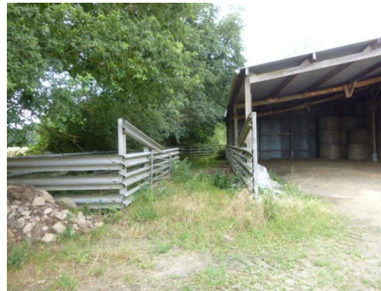
Figure 4 : Hangar de stockage situé à proximité de l'éolienne E2
