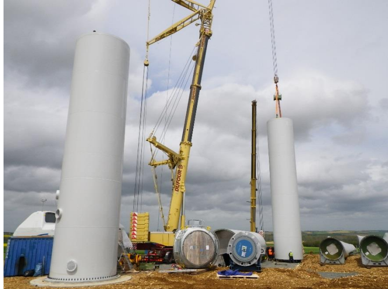
Figure 118 : Portion de mât acier pour une éolienne NORDEX (Source : NORDEX)
