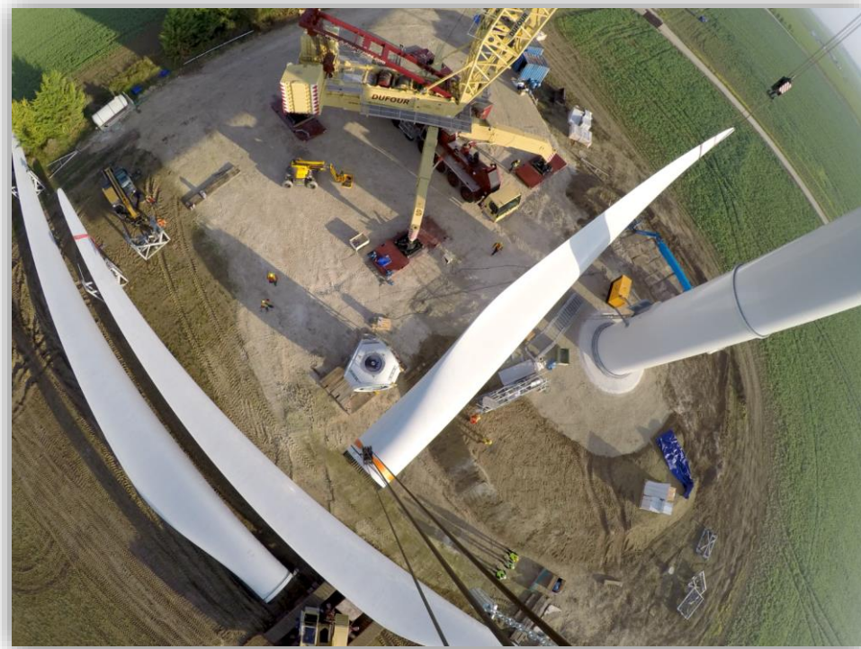
Figure 124 : Vue sur une plateforme de montage depuis la nacelle (Source : NORDEX)
