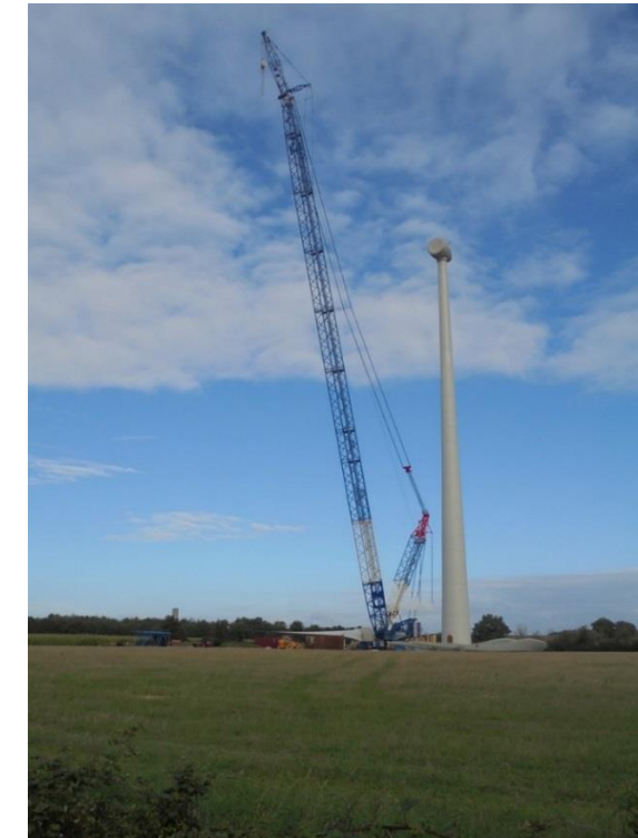
Figure 158 : Grande grue sur un chantier éolien (Source : Photos TP)
