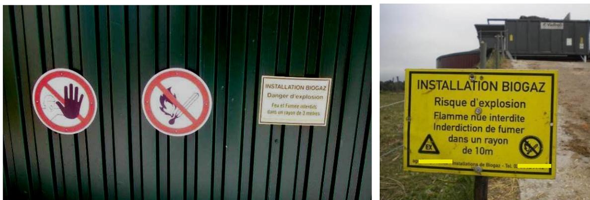
Figure 48 : Exemple de signalétique de zone ATEX sur le bardage d'un digesteur et à proximité des installations (photos NCA – 2011 et 2012)
