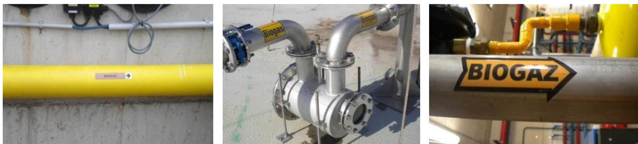
Figure 30 : Exemples de repérage des canalisations de biogaz
