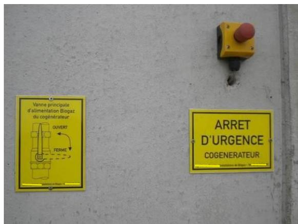
Figure 49 : Exemple de dispositif coup de poing à l'extérieur d'un local de cogénération
