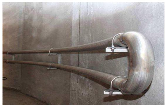
Figure 16 : Réseau de chauffage interne en inox
