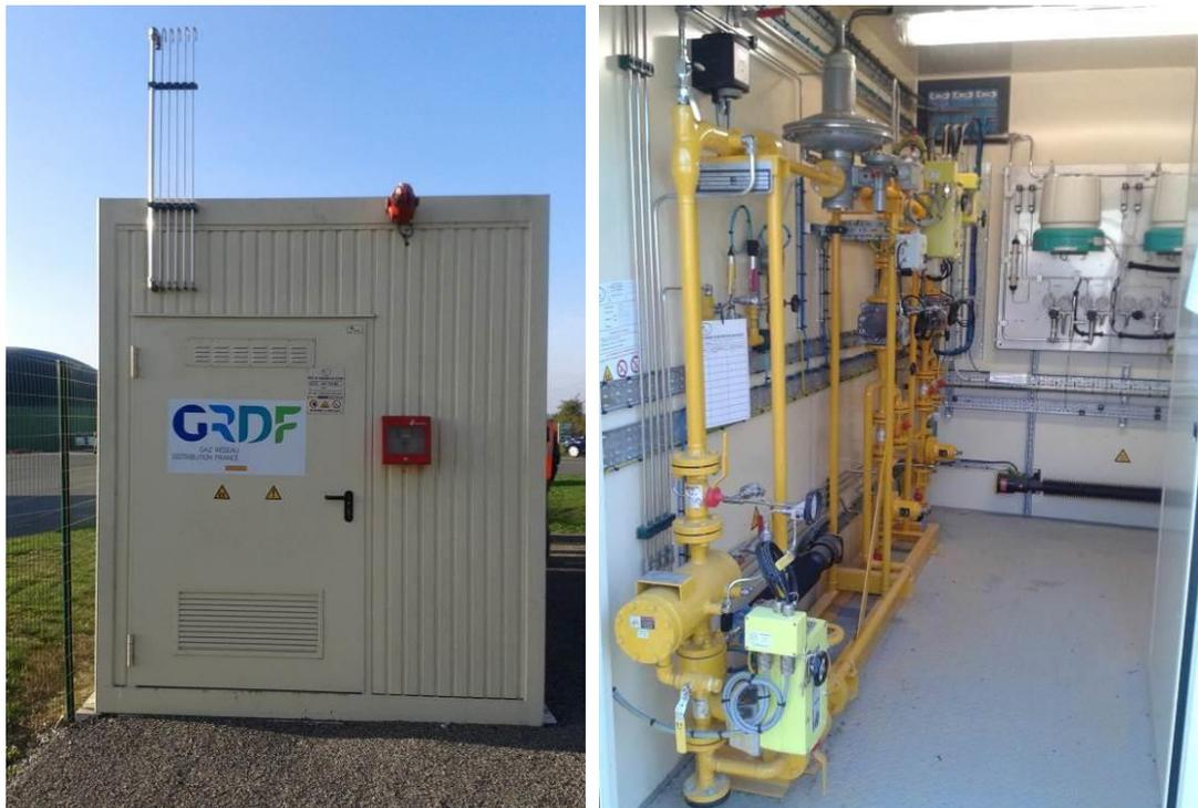
Figure 25 : Vues intérieure et extérieure (arrière) d'un poste d'injection GrDF
