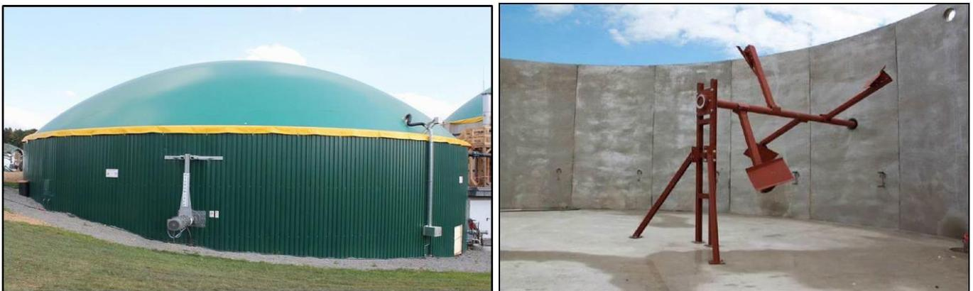
Figure 15 : Structure d'un digesteur et agitateur à pâles
